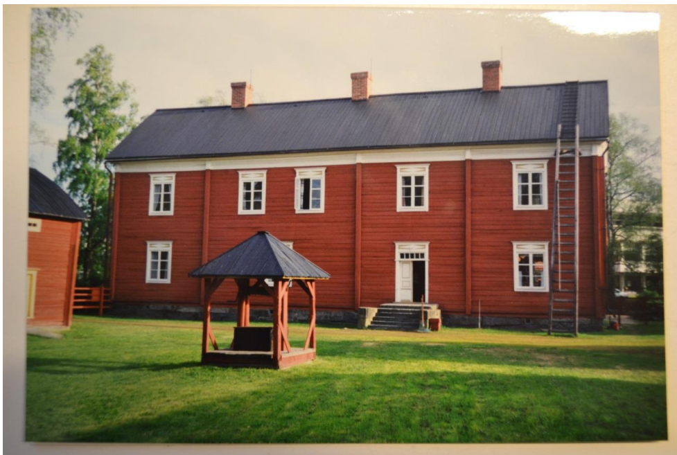
Kuva 21 Kattoja tervauksen jälkeen vuonna 1994. Lähde KYH Ry.
