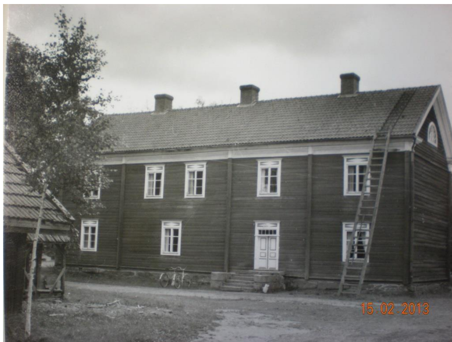
Kuva 8 Päärakennus ennen korjaustoimenpiteitä. Lähde: KM Kta.
