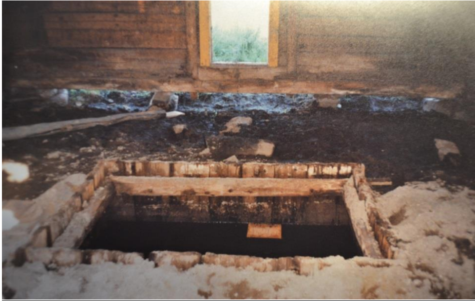
Kuva 22 Tallin rakenteiden korjaus vuoden 2000 tienoilla. Lähde Kyh Ry.
