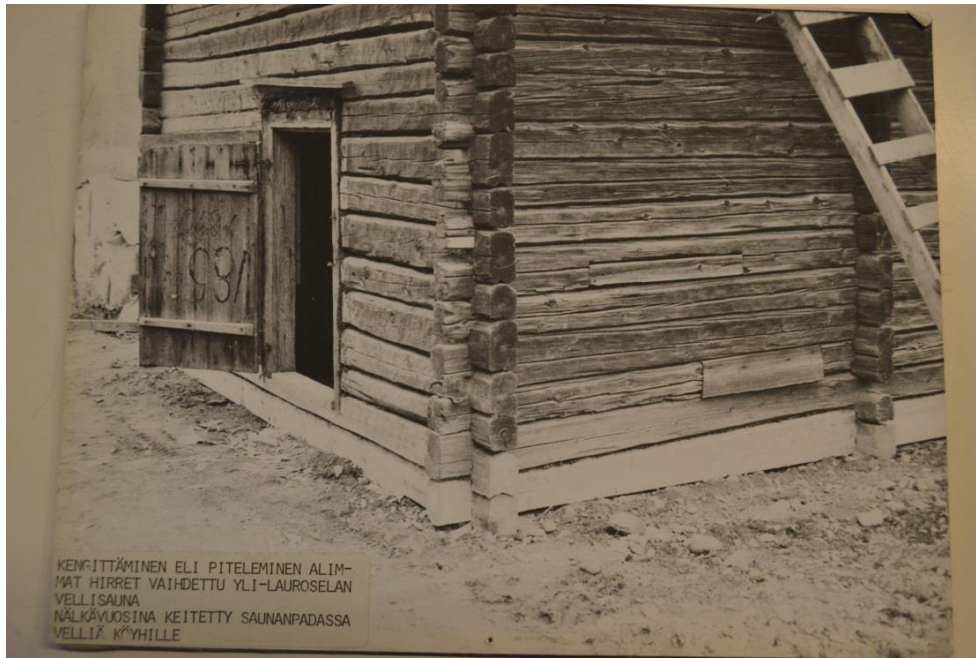
Kuva 16. Vellisaunan hirsien paikkaus. Lähde: Rakennuskonservointi -kirja s. 30.
