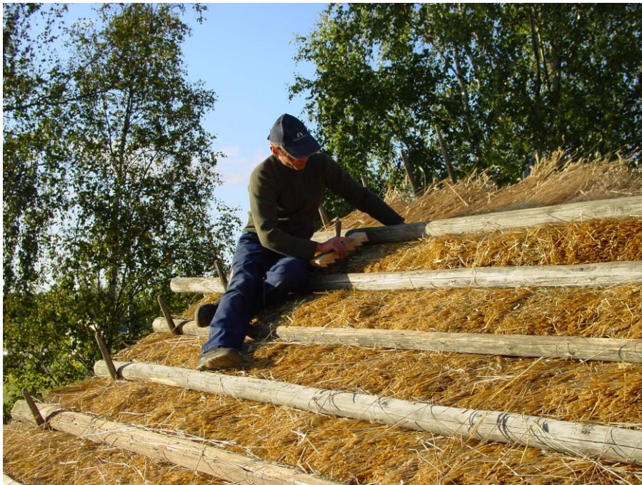
Kuva 30 Risto Holopainen tekemässä puuliiterin olkikattoa perinteisin työmenetelmin
