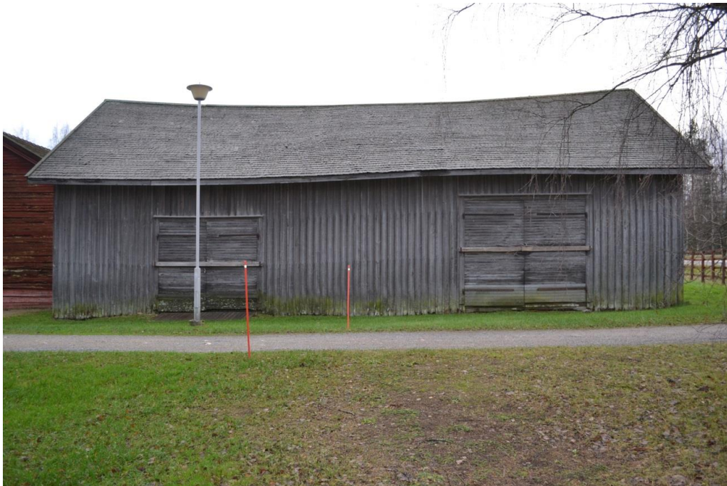
Kuva 25 Harmaan ladon kannattajan nurjahdus on aiheuttanut harjalinjan painumisen.
