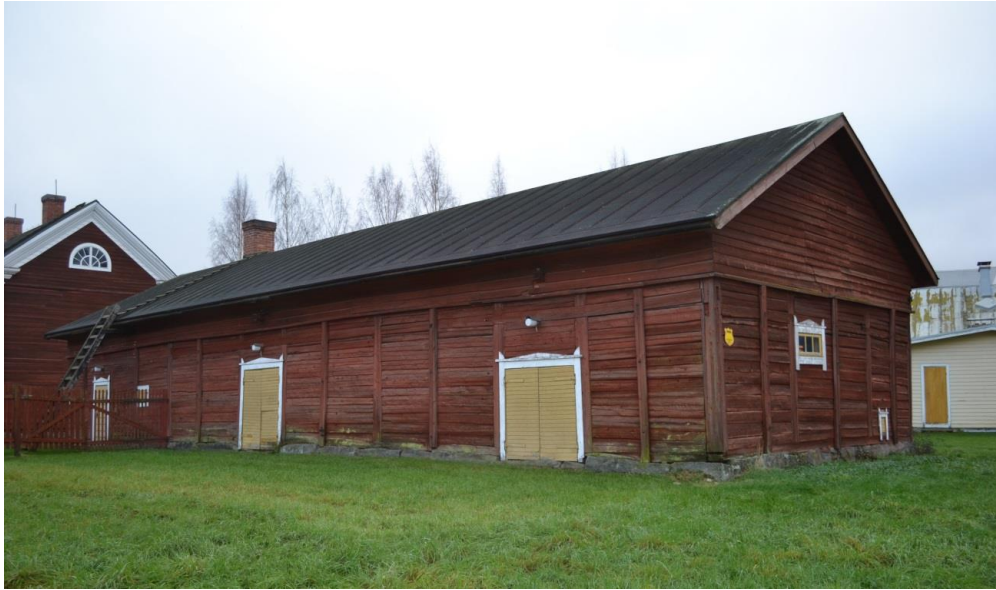
Kuva 4 Mallipiirustusten mukaan rakennettu varhopatsasnavetta
