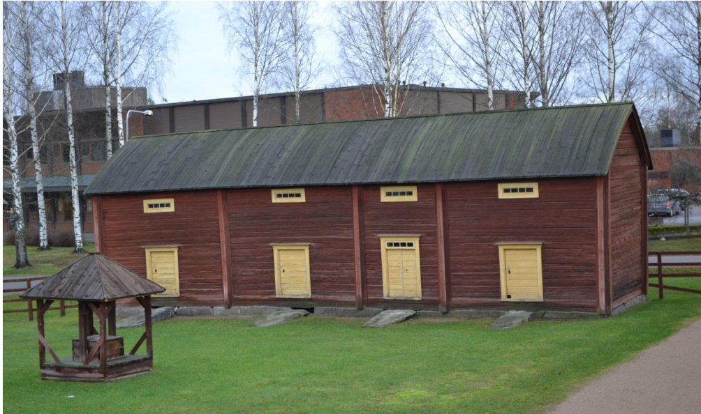
Kuva 6 Luttirati ja kaivo
