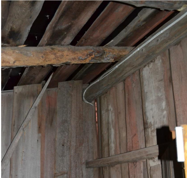
Kuva 27 Hyysin katon alusrakenteet on tehty vesivanerista.
