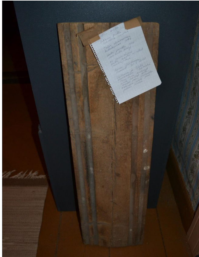
Kuva 15 Muistilapun mukaan tämä on pukkien päältä sahattua lautta, joka on ollut tallin alimmaisena kattolautakerroksena. Oli oletettavasti ensimmäinen katto koska laudassa ei ollut naulan jälkiä. Katto on purettu vuonna 1972 ja tehty uusi katto. Viitanen ja Ojala olivat kohteen ensimmäisiä työmiehiä. Aarne Viitanen on tuonut laudan museoon vuonna 2008.
