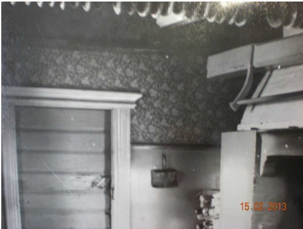
Kuva 20 Tuvasta poistettiin 1970-luvun korjauksessa tapetit. Lähde: KM Kta.
