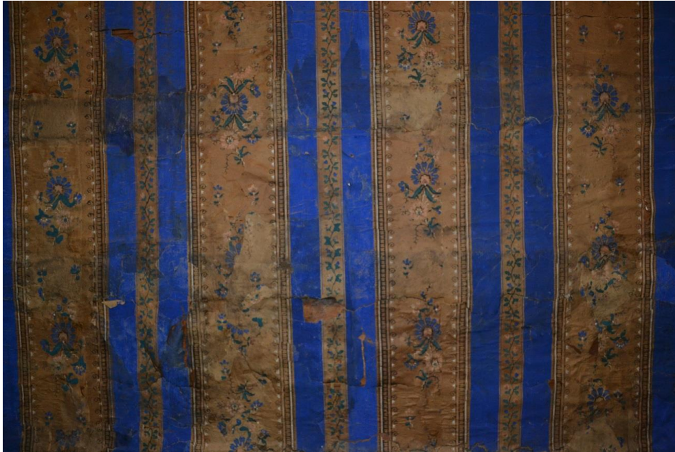
Kuva 19 Vanhan tapetin paikkauksia ja vaurioita yläkerran kamarin 7 länsiseinällä
