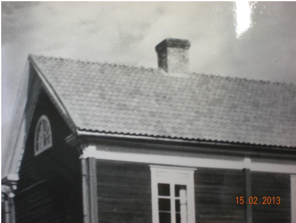
Kuva 14 Yli-Lauroselan savitiilikatto. Lähde KM Kta.
