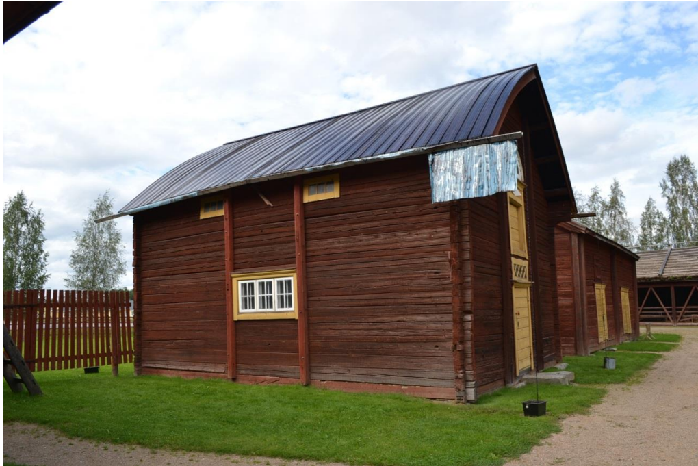
Kuva 26 Tallin uusi lautakatto tervattiin uudelleen vuonna 2012.
