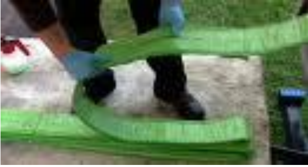
Kuva 14. Putken sujutusta
