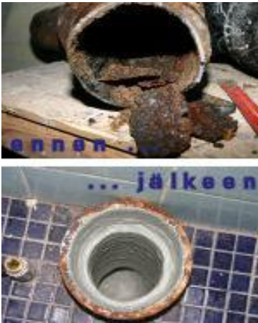
Kuva 17. Tubus-pinnoitusmenetelmä
