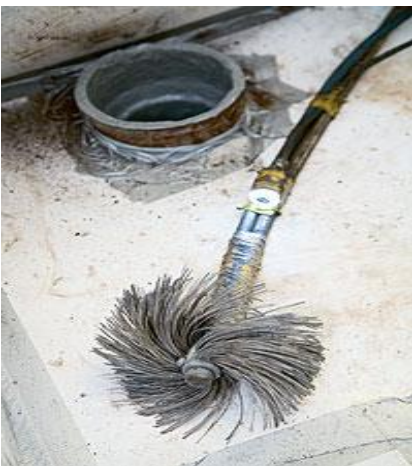
Kuva 16. Dakki-menetelmässä pinnoitustyökalu on harja, jolla pehmeä epoksimassa levitetään keskipakovoiman avulla putken sisäpinnalle
