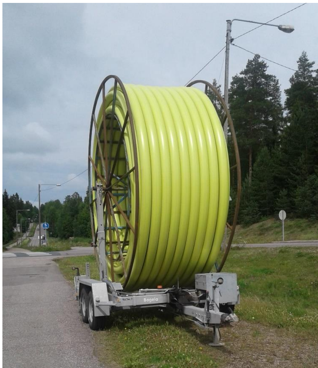
Kuva 2. Porauksen jälkeen vedettävä muoviputki
