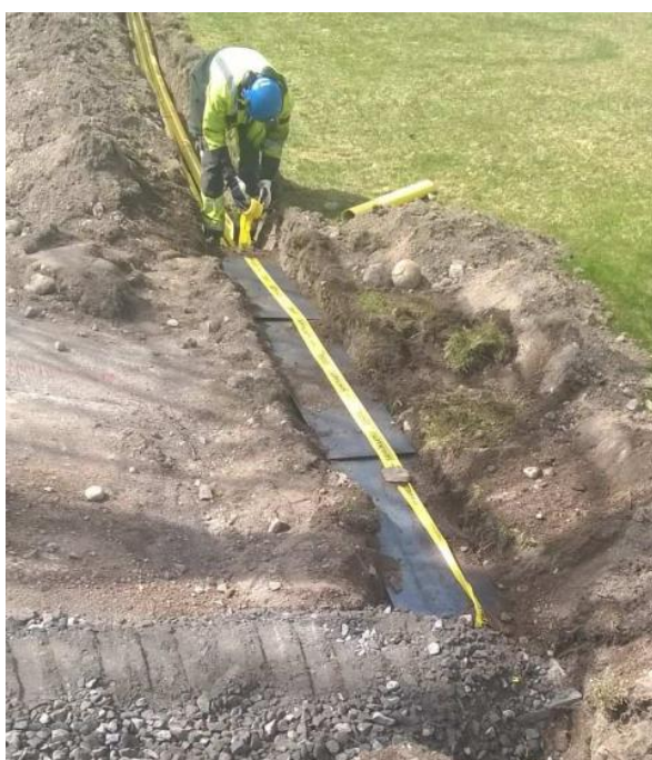
Kuva 4. Teräsbetonisuojaus, jonka päällä keltainen varoitusnauha
