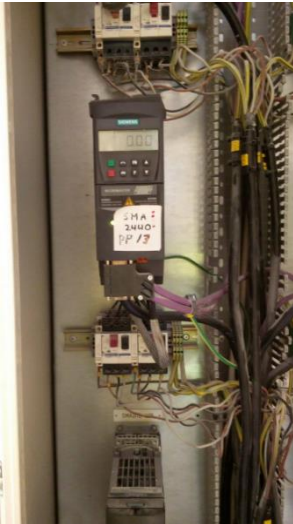
KUVA 9. Korvattava Siemens Micromaster 440 -taajuusmuuttaja
