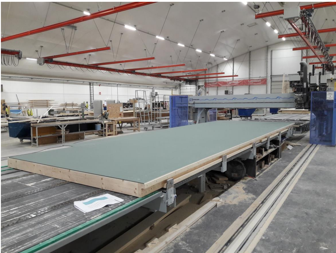
KUVA 4. Tuulensuojalevyt asennettuna levypöydällä
