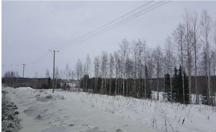
Kuva 16. Muuntamon paikka sekä 10 kV avolinja
