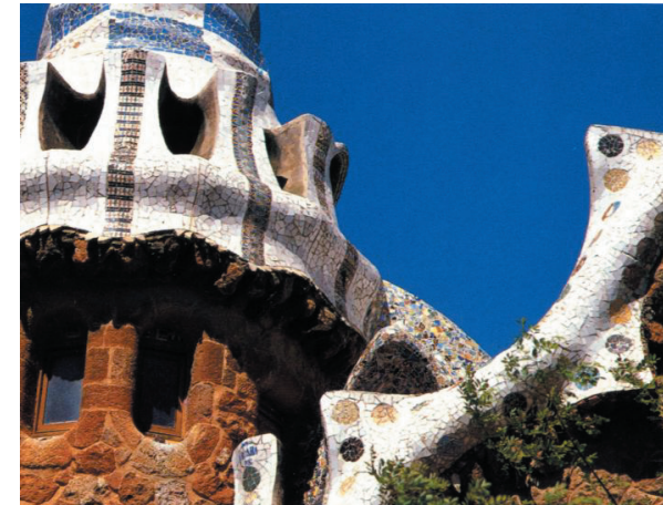
Kuva 29 Sisäänkäynnin rakennuksen kattomosaiikkia (Van Zandt 1995)
