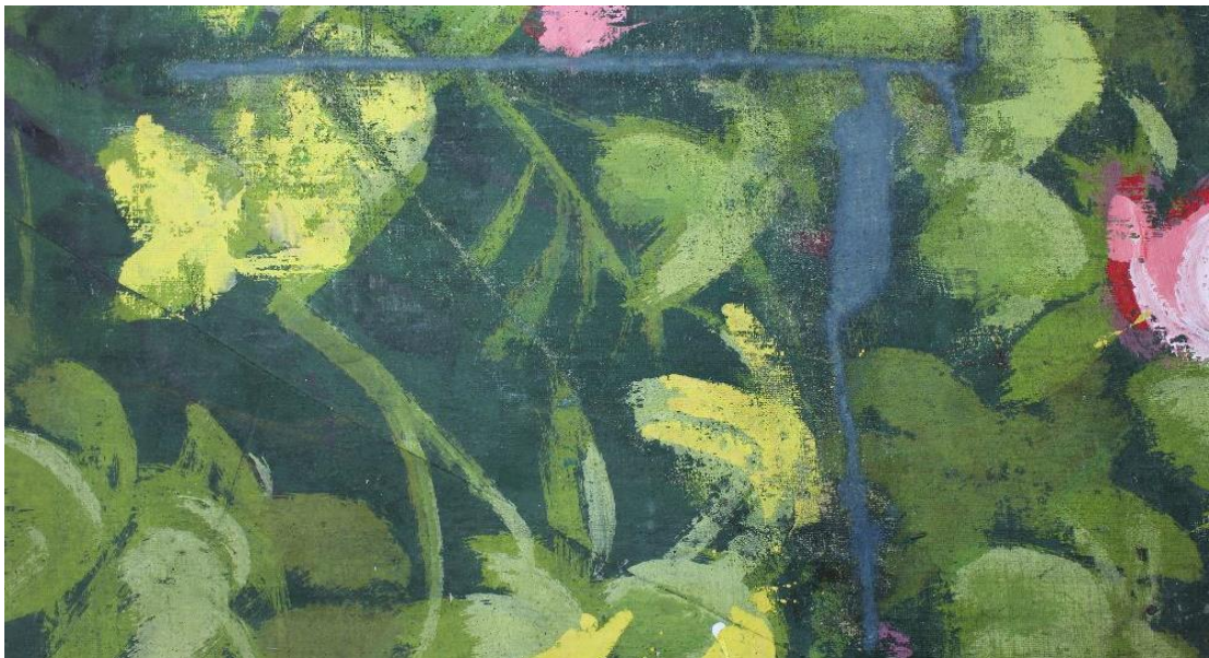
Kuva 34. Valmistettu kittaus oikeanpuoleisessa paikkauksessa.
