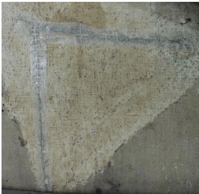
Kuva 31. Stabiltex on kiinnitetty paikatus repeämän taustalle.
