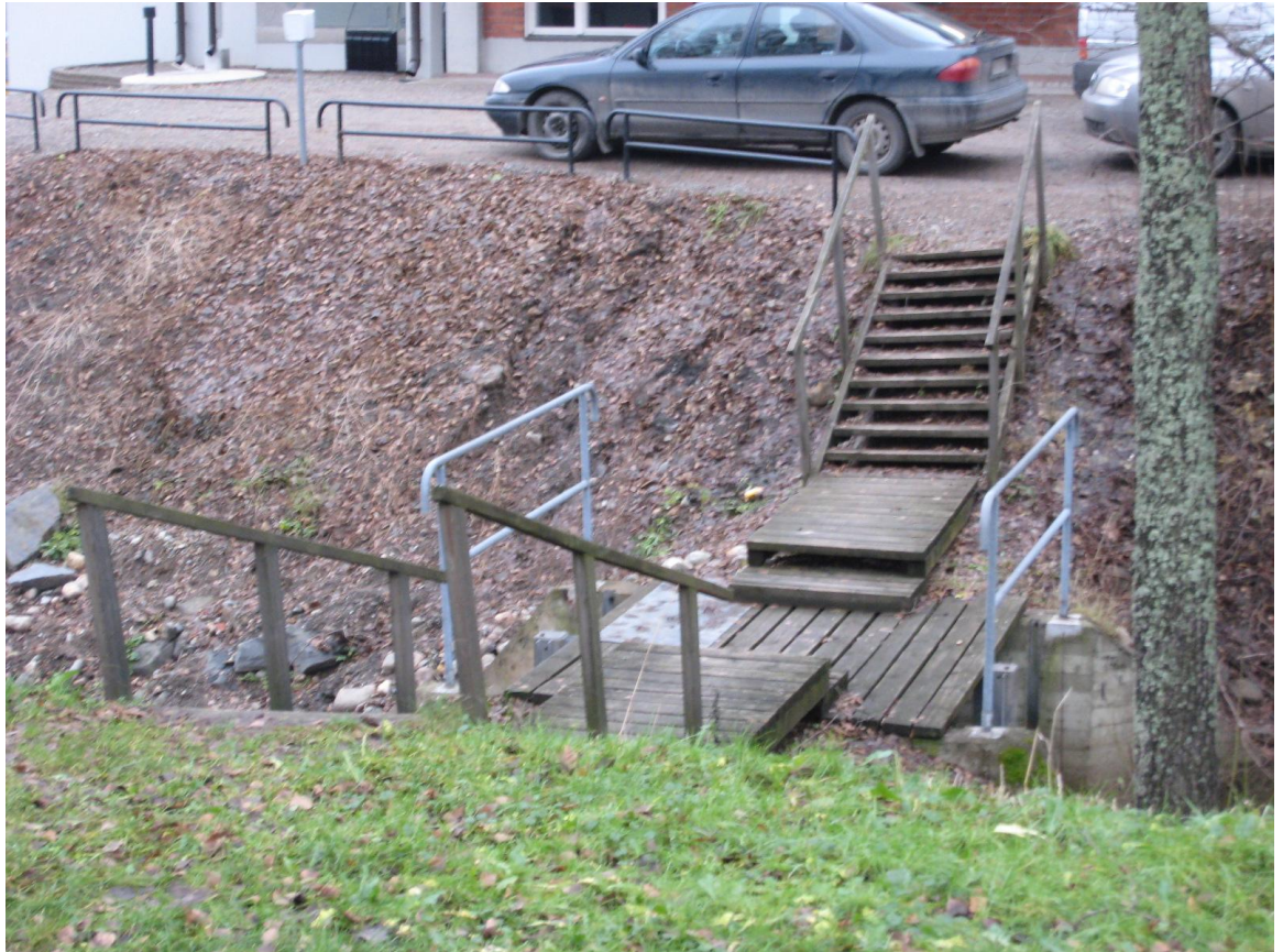
Kuva 1. Ilosaaren vanha kevyenliikenteensilta.
