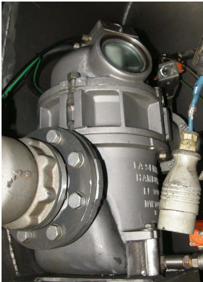
Kuvio 7: FMC Seningin valmistama ilmanerotin (kuva K.P. Säiliöt Ay)
