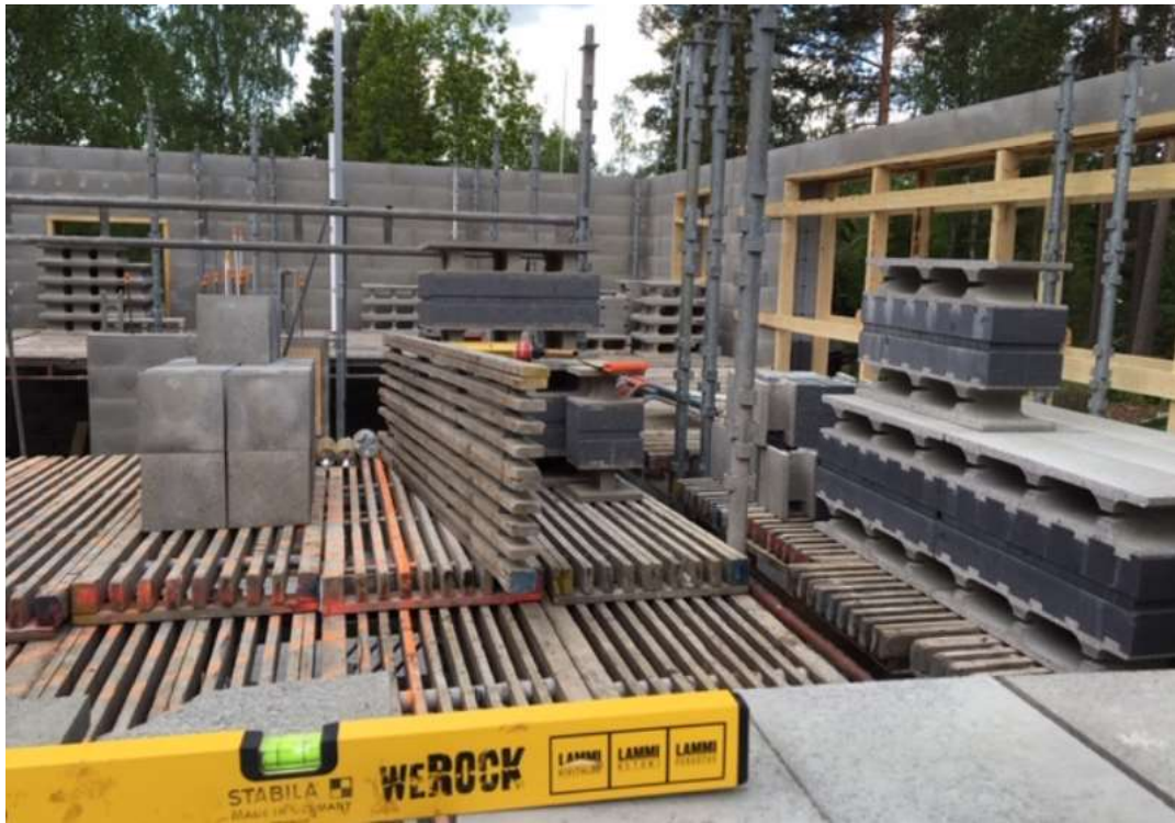
Kuva 2. Lammin vatupassi työmaalla. (Kaj Enberg)
