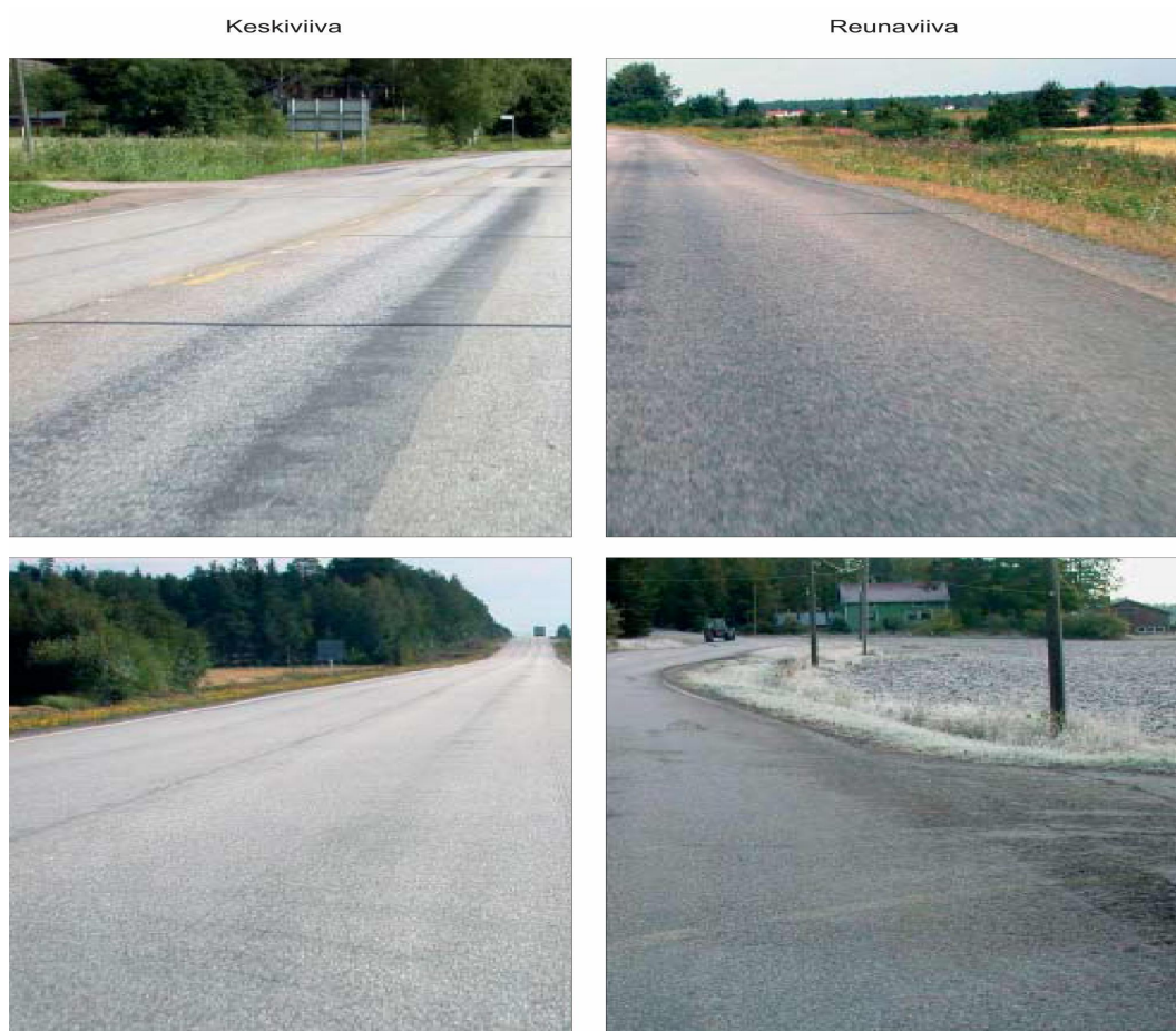
Kuva 2. Kuntoarvo luokassa 1, tiemerkin yläpuolet ovat kuluneet tai reunapalteen peitossa. (Tiemerkintöjen kuntoluokitus)
