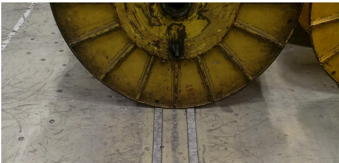
Kuva 13. Kelakisko lattialla säilytettäville keloille
