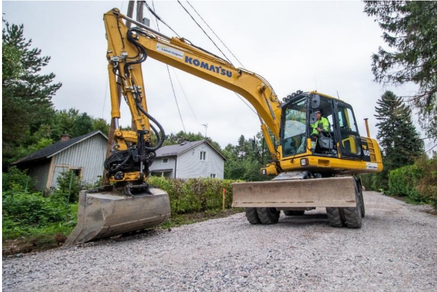
Kuva 13. Infrakitiin liitetty 3D-koneohjausta käyttävä kaivinkone (Panu Mäkinen)
