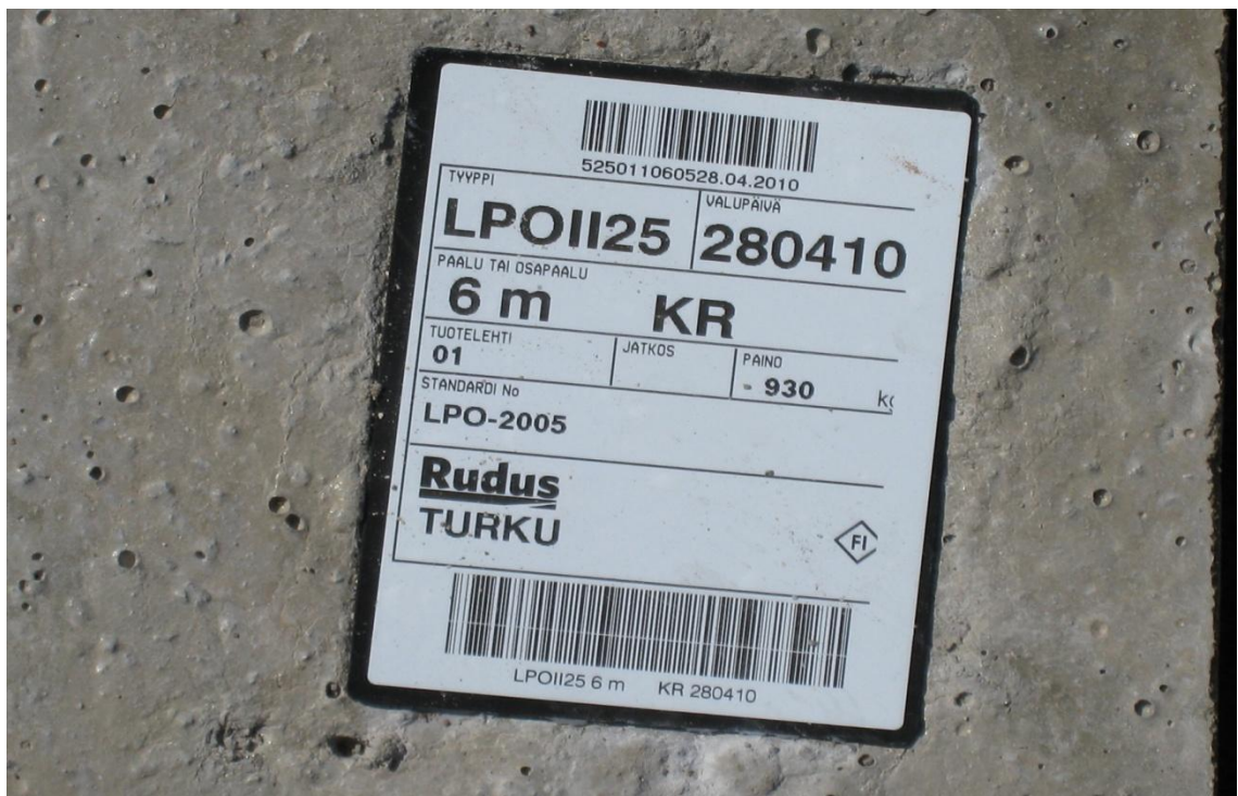
Kuva 2. Teräsbetonipaalun valmistustiedot (Rudus 2010)
