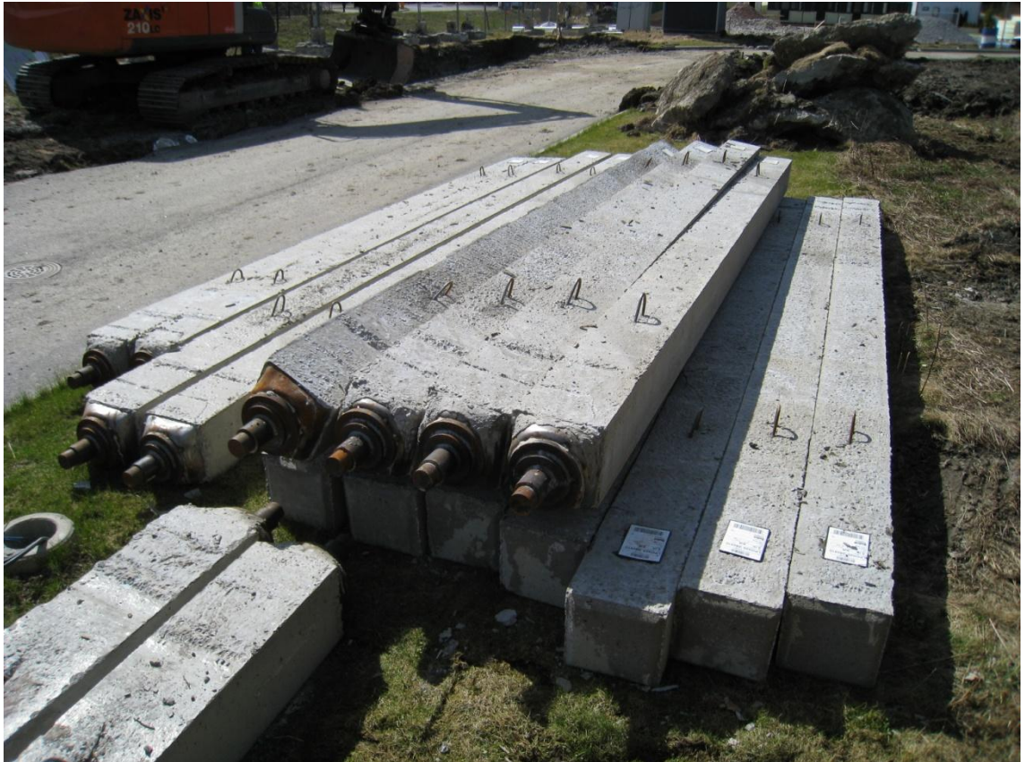
Kuva 14. Paalujen säilytys
