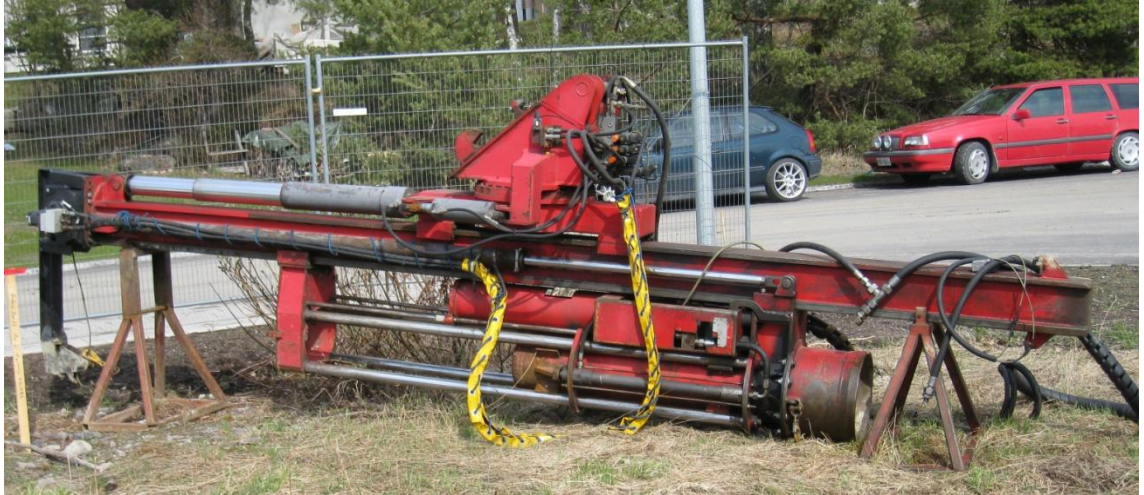
Kuva 19. Teräsputkipaalujen lyöntilaite Fampo
