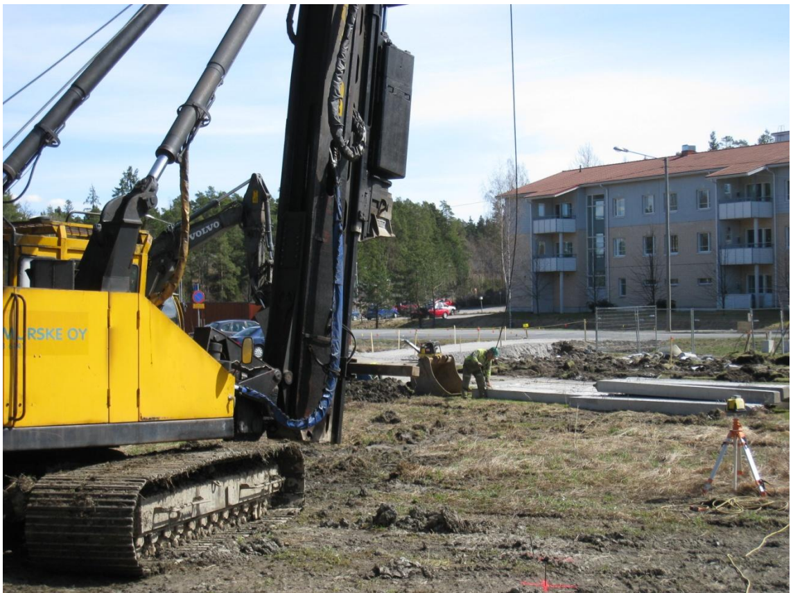
Kuva 15. Paalutuskone ja apumies työssään
