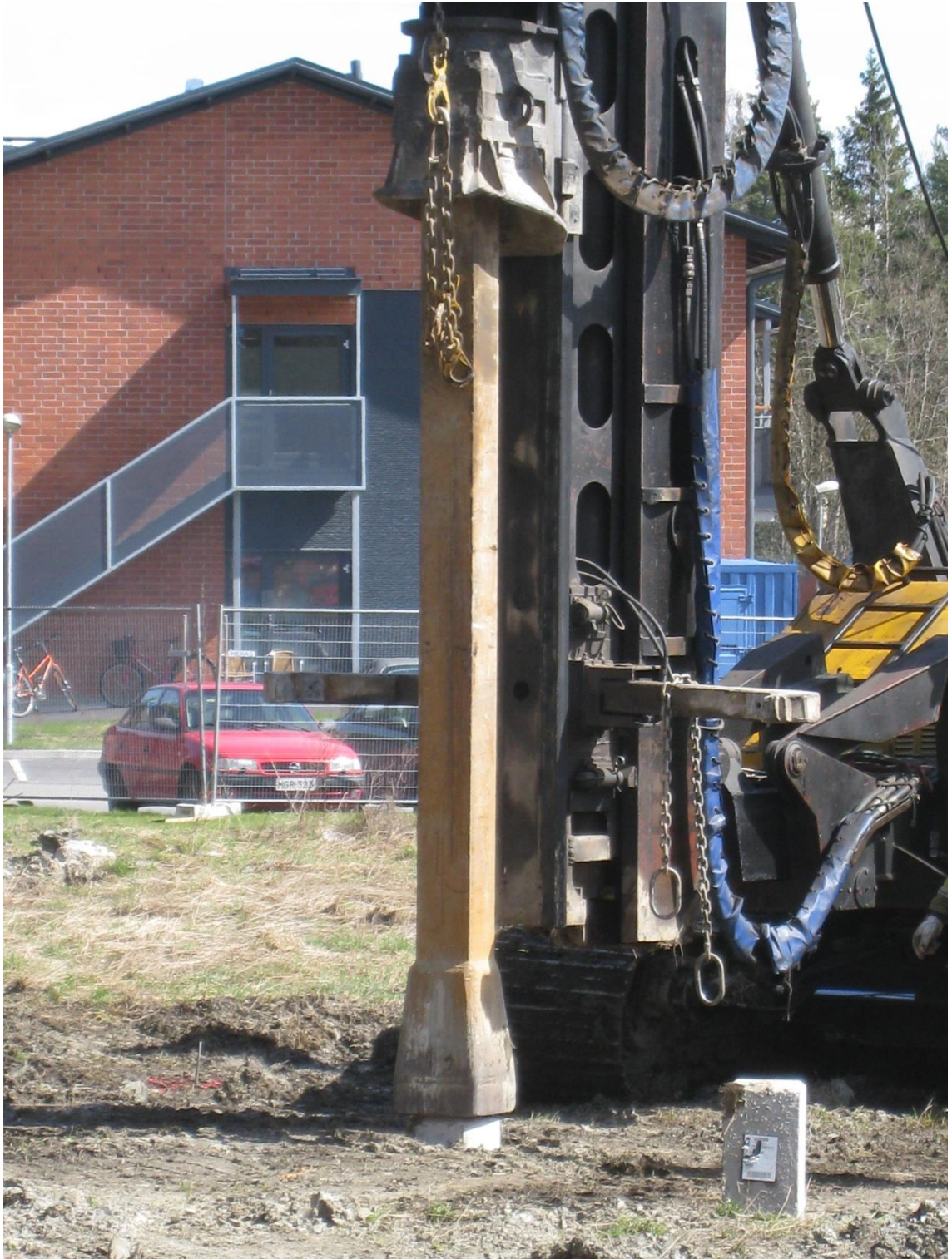
Kuva 11. Apupaalun käyttö paalutuksessa
