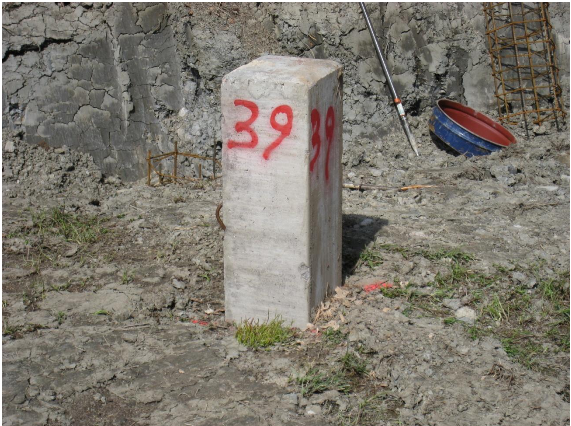
Kuva 1. Teräsbetonipaalu maahan lyötynä
