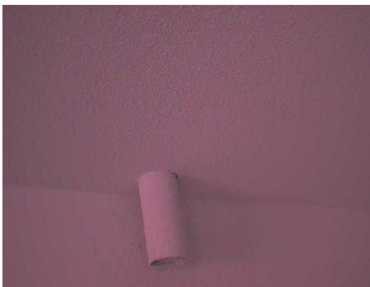
Kuva 7: Lämpökameralla otettu normaalikuva ilmastointiputken läpiviennistä.
