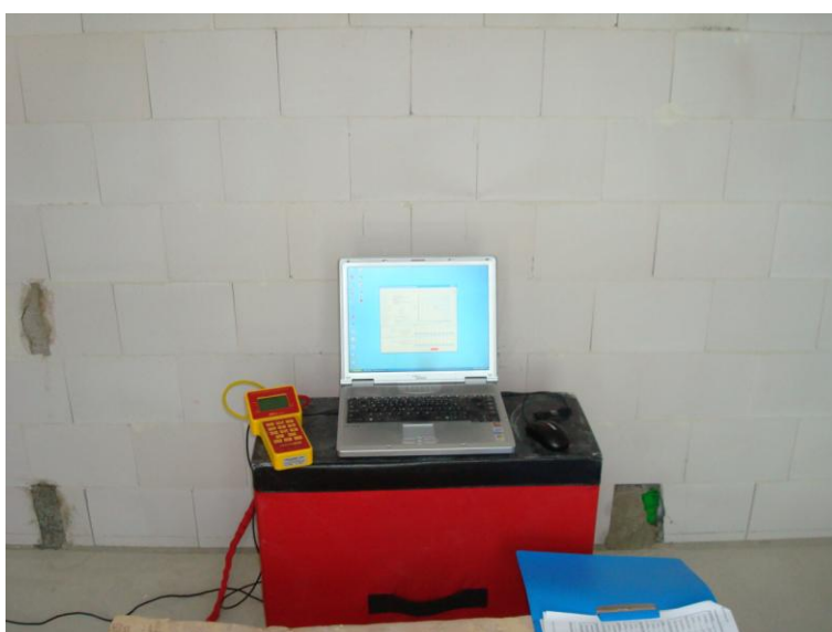
Kuva 6: Tietokone laskee ilmavuotoluvun mittauspaikalla
