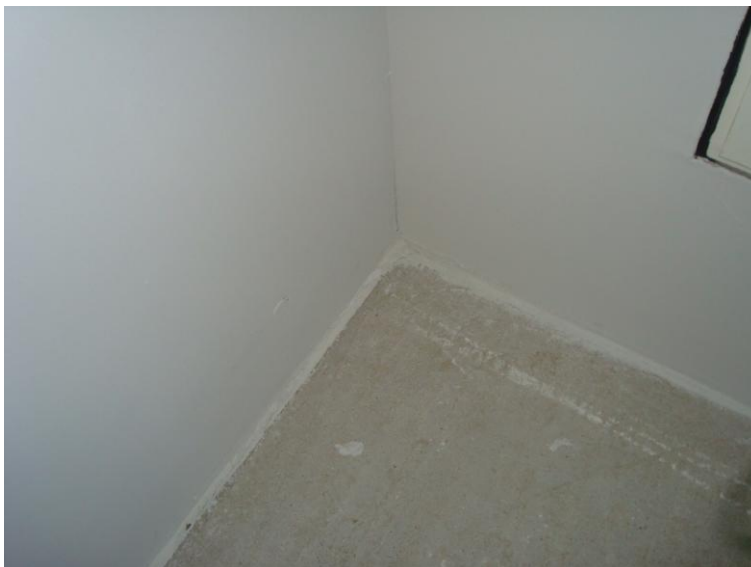
Kuva 19: Lattian raja kitattu ulkoseinän osalta
