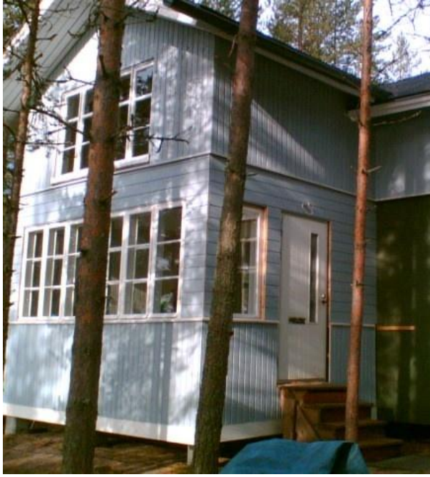
Kuva 30. Uusi kuisti ilman lopullista terassia ja portaita
