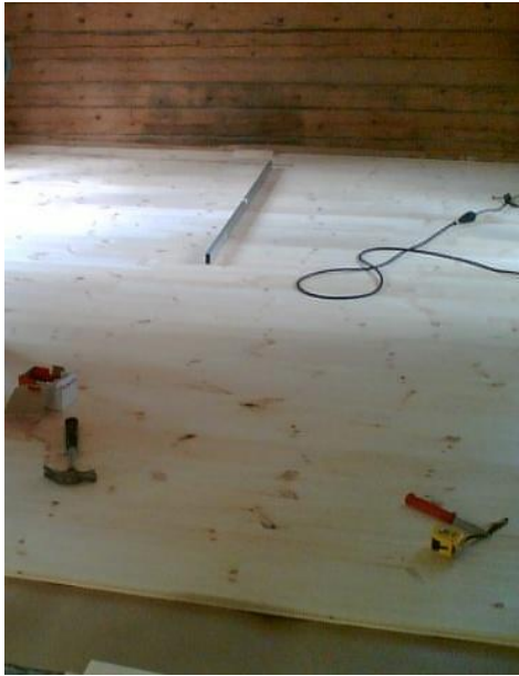
Kuva 45. Lattiamateriaalin asentaminen
