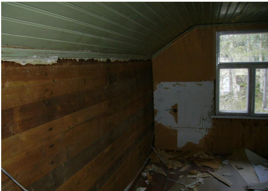
Kuva 11. Ullakkohuoneen pintamateriaalien poistaminen
