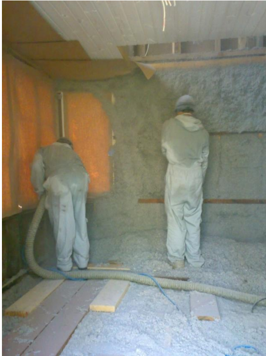
Kuva 32. Kuistin lämmöneristys puukuitueristeellä
