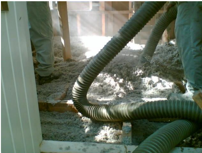
Kuva 44. Lattian lämmöneristys puhallettavalla puukuitueristeellä
