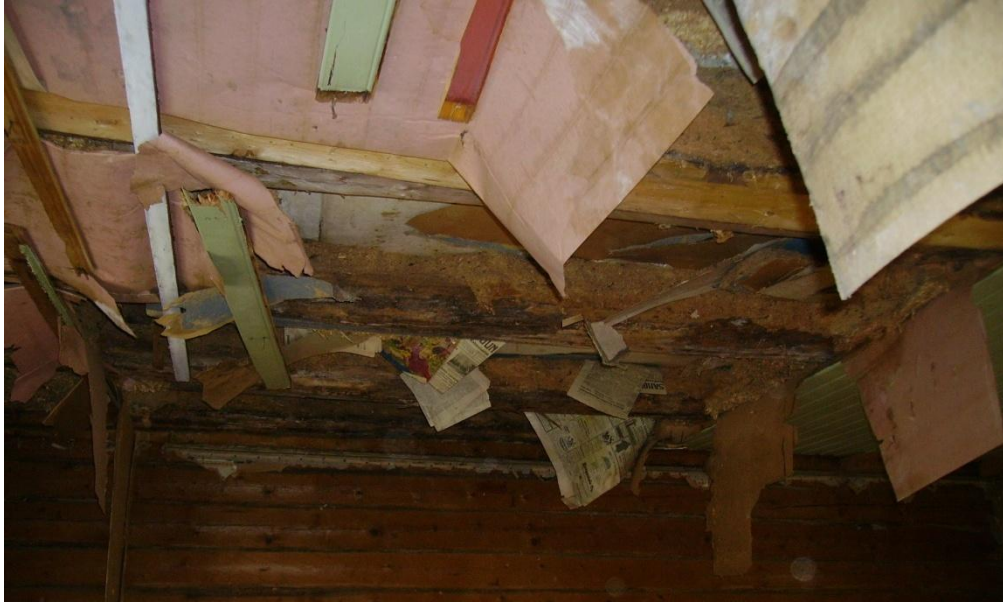
Kuva 12. Välipohjan täytteiden pudottaminen alakertaan
