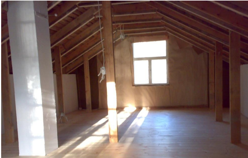
Kuva 47. Keskenräinen ullakko ja valmis välipohja
