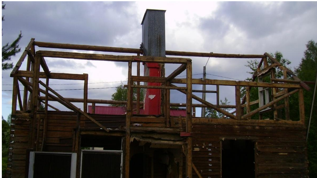
Kuva 14. Kattorakenteiden purku
