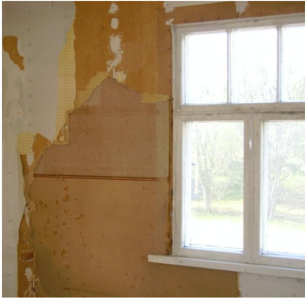
Kuva 7. Sisäpuolelta poistettavia materiaalikerroksia
