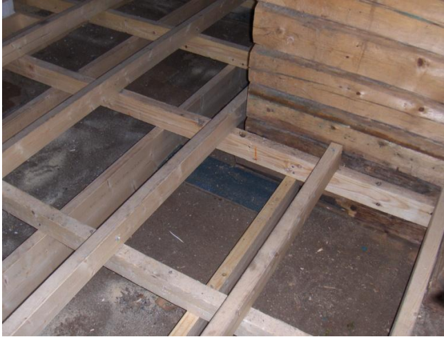
Kuva 43. Lattiarakenne ilman eristystä
