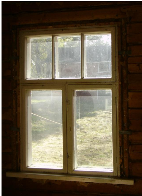
Kuva 9. Lähtötilanne ikkunoiden irrottamiseen
