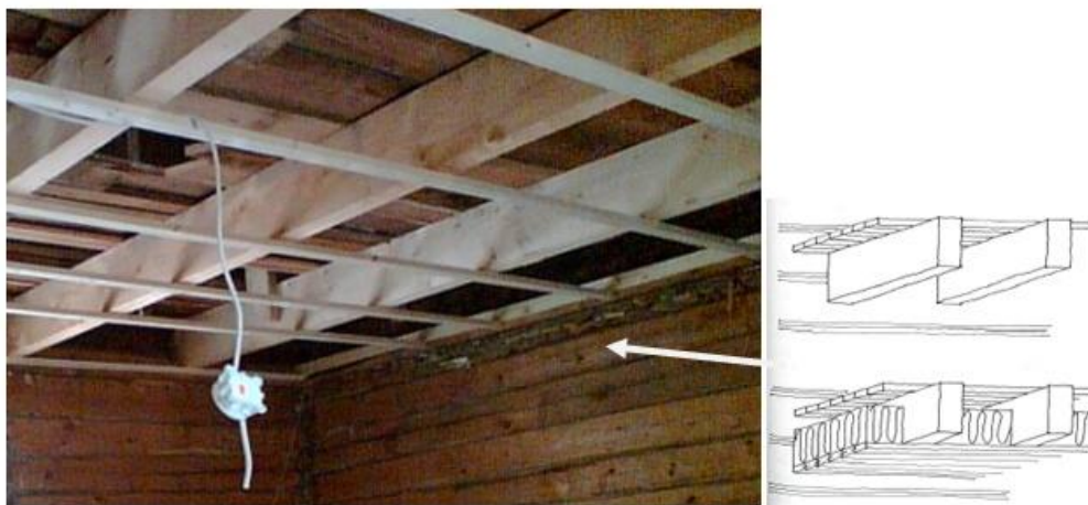
Kuva 46. Välipohjarakenne alakerrasta katsottuna [23.]
