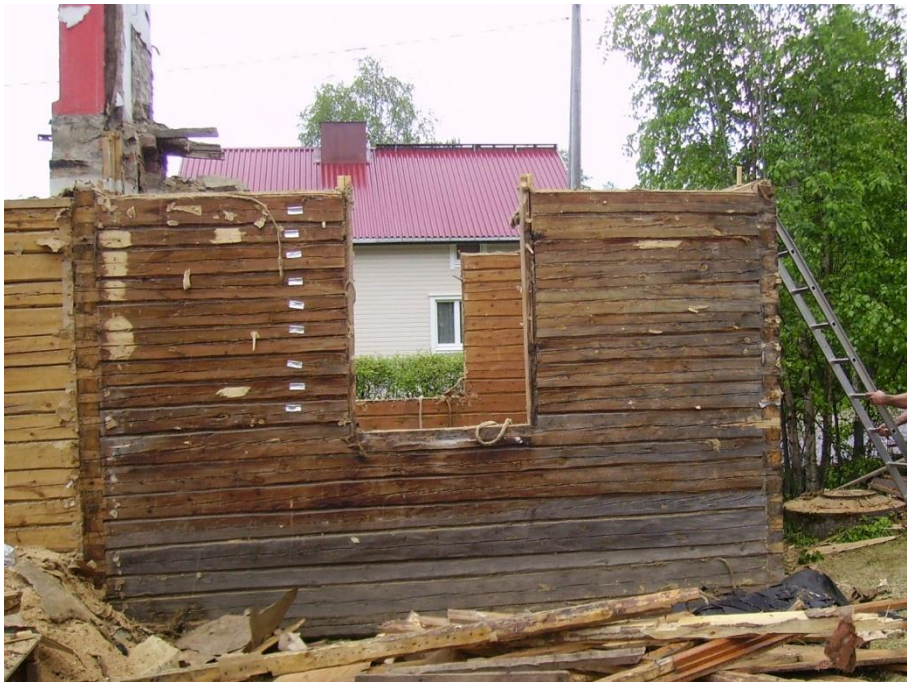
Kuva 15. Hirsirungon purkaminen
