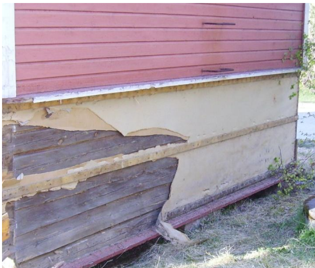
Kuva 8. Ulkopuolelta purettuja pintarakenteita
