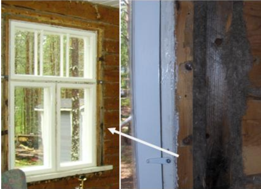
Kuva 50. Ikkunan kiinnittäminen
