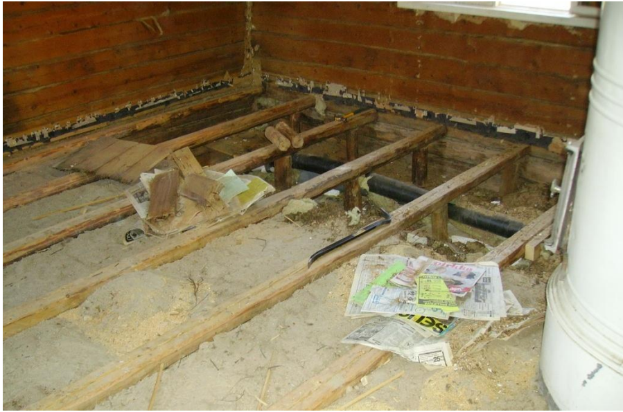
Kuva 10. Alapohjan purkaminen
