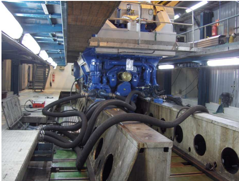
Kuva 15. Koeajosellissä W32-moottori, jossa ei ole generaattoria. /3/
