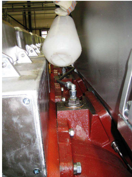
Kuva 6. Moottorin vesijärjestelmän tiiveystestaamista. /8/
