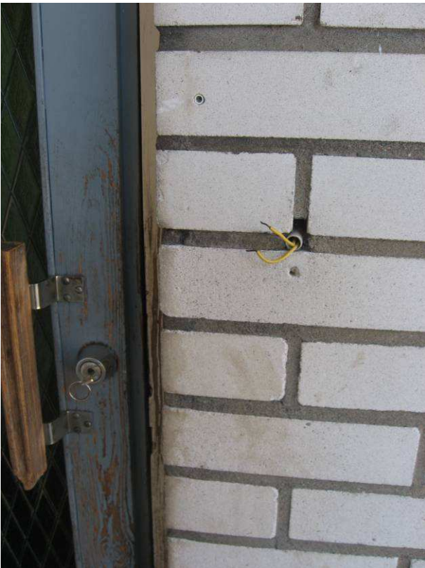
kuva 1. suojakuori sekä keskiön suojakuori irronnut puhelinpistorasiasta. suojakuori myös tavallisille pistorasioille.
