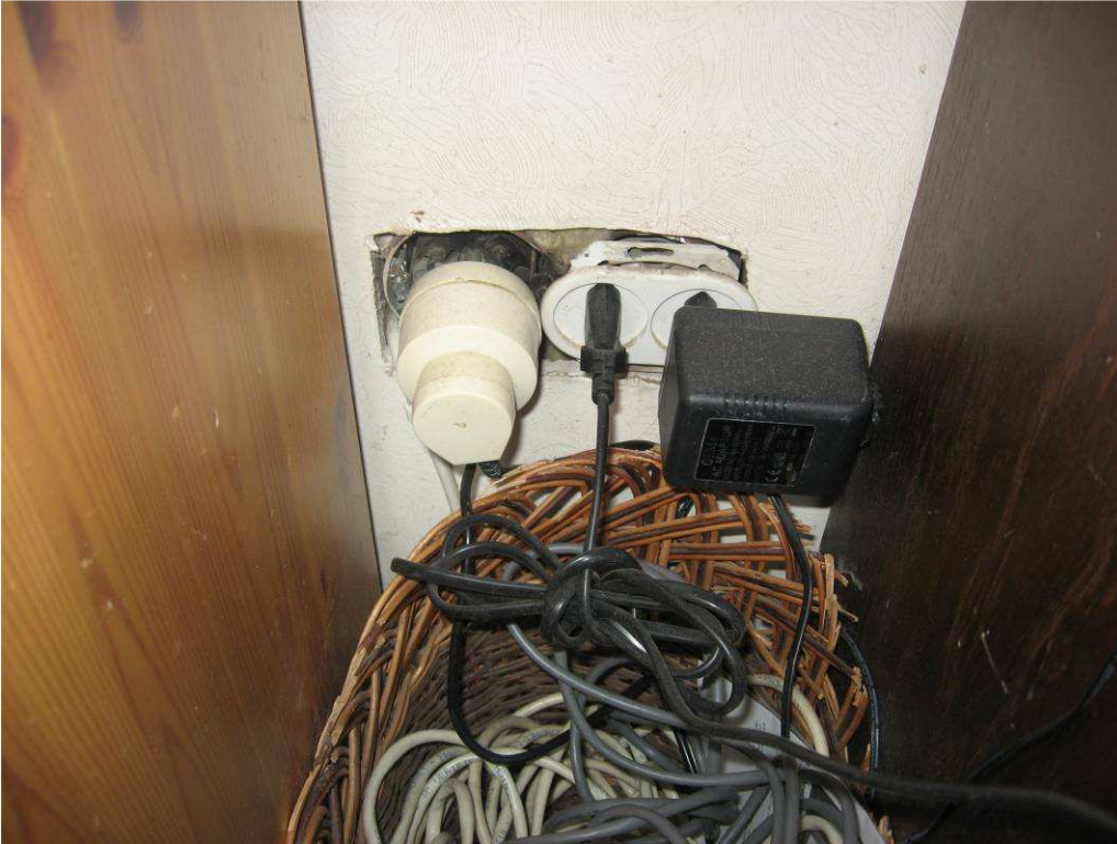
kuva 1. suojakuori sekä keskiön suojakuori irronnut puhelinpistorasiasta. suojakuori myös tavallisille pistorasioille.
