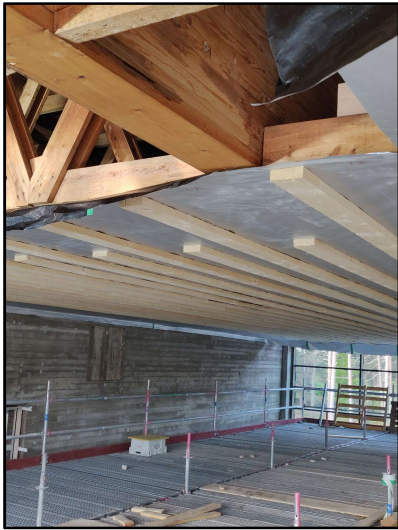
Kuva 7. Kankaanpään liikuntakeskuksen höyrinsulun asennusta
