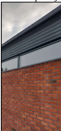
Kuva 4. Uudet ikkunat sekä uusi puuverhous näkyvissä, tiiliseinään suoritetaan vielä puhdistus soodapuhaltamalla
