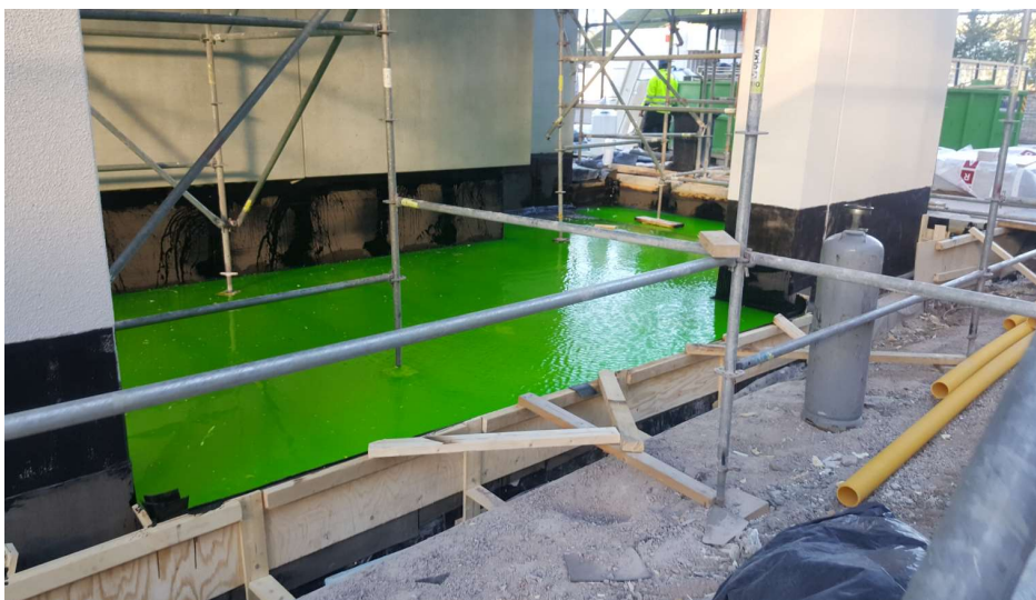
Kuva 4. Vedenpainekeeseen liittyvä väliaikainen padotuseste (kuvaaja Kalle Kupsu)
