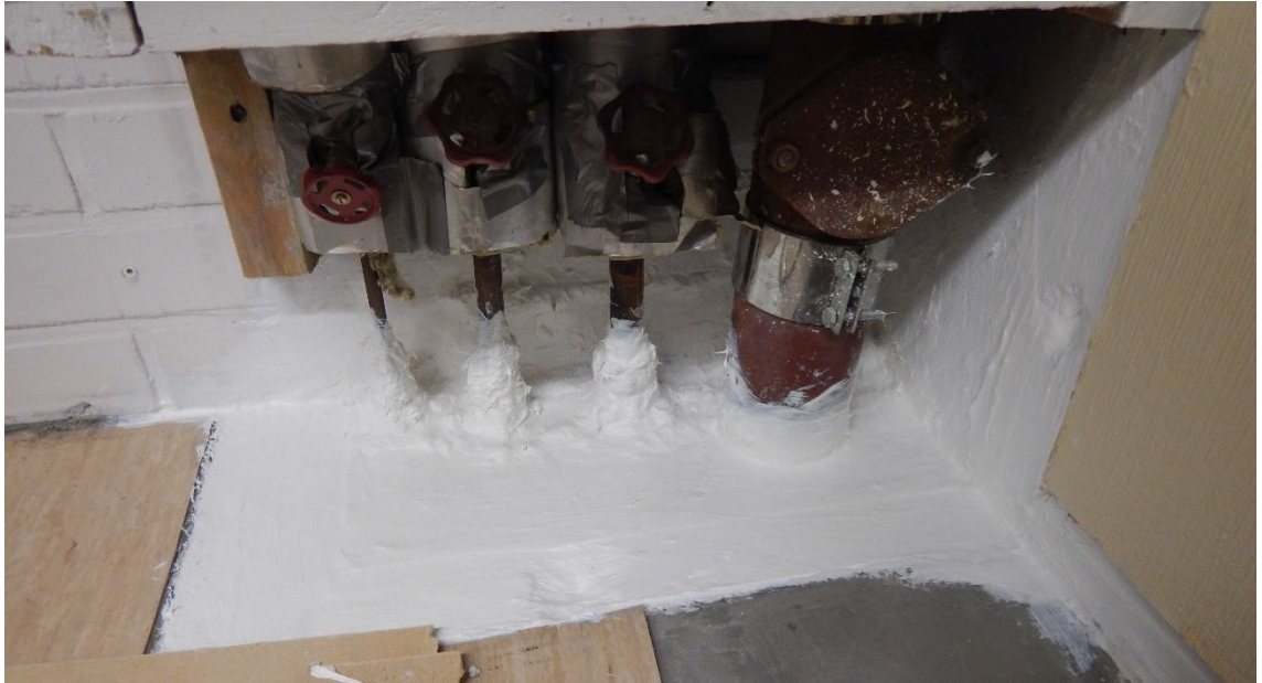
Kuva 10. Siveltävällä pinnoitteella ja vahvikenauhalla tiivistetyt läpiviennit (Vahanen Rakennusfysiikka Oy 2016)
