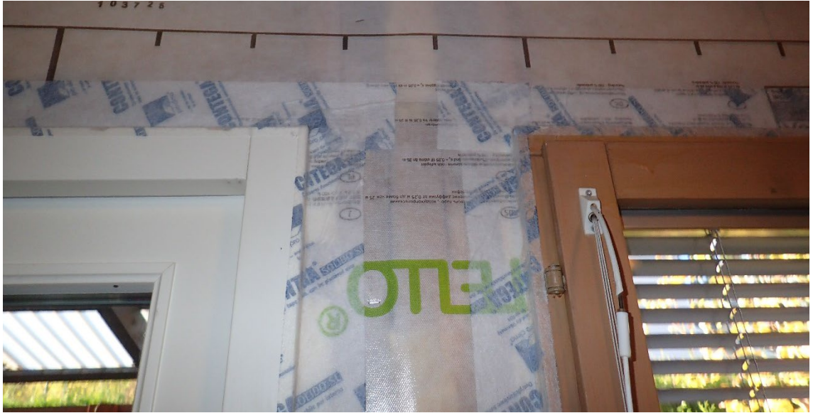
Kuva 11. Liitosnauhamenetelmällä tiivistetyt höyrynsulkukalvon liitokset (kuvaaja Mikko Koskivuori, Vahanen Rakennusfysiikka Oy 2017)
