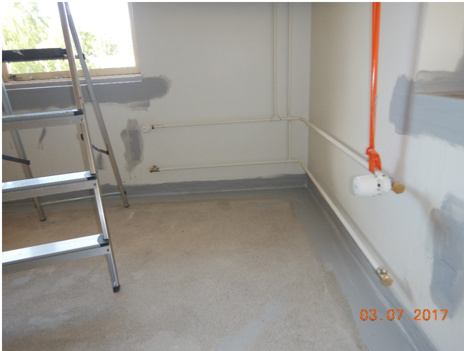
Kuva 5. Tiivistyskorjaus edellyttää yleensä pintamateriaalien poistoa (Vahanen Rakennusfysiikka Oy 2017)
