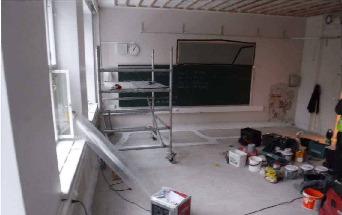
Kuva 12. Luokassa yksi tiivistettiin lattia-seinäliittymät, ikkuna-seinäliittymät, yläpohja-seinäliittymät, välipohjalaatan halkeamat, läpiviennit ja alakaton puurakenteiset koolaukset. (Vahanan Rakennusfysiikka Oy 2017)
