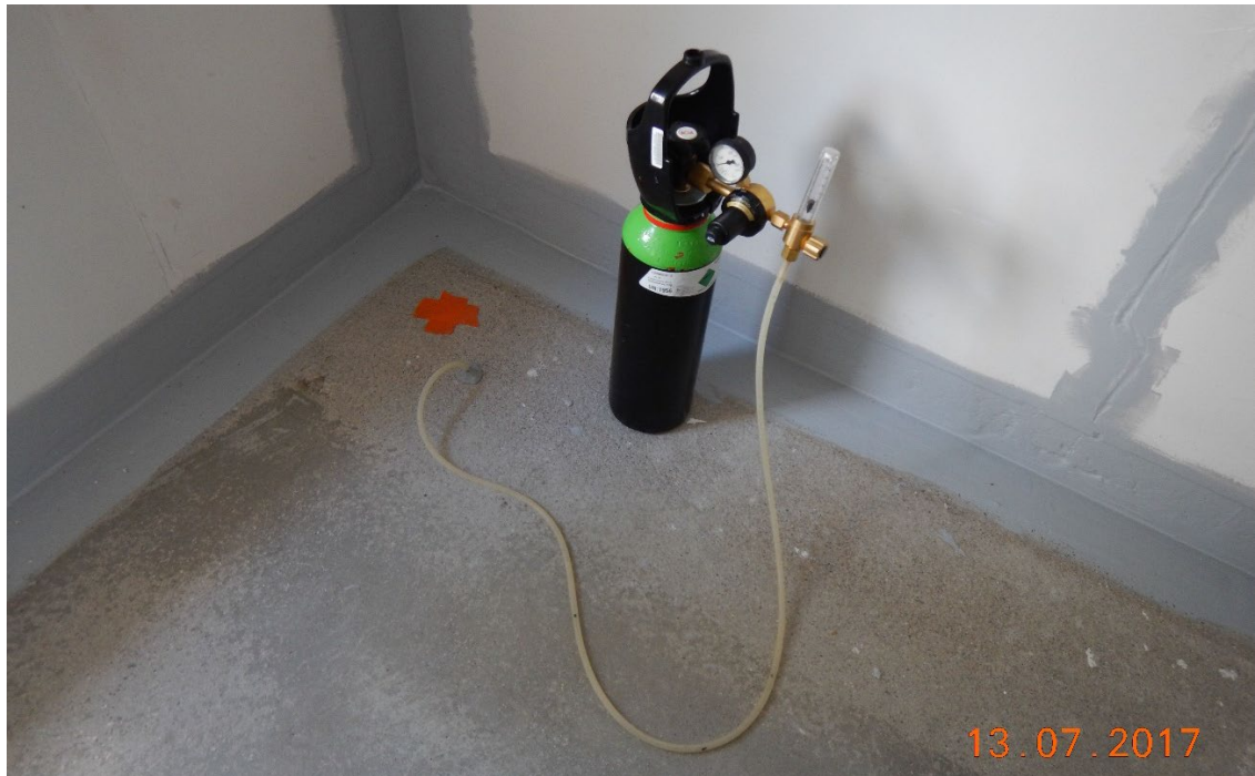
Kuva 6. Alapohjarakenteeseen lasketaan merkkiainekaasua tiivistyskorjausten laadunvalvontaa varten (Vahanen Rakennusfysiikka Oy 2017)
