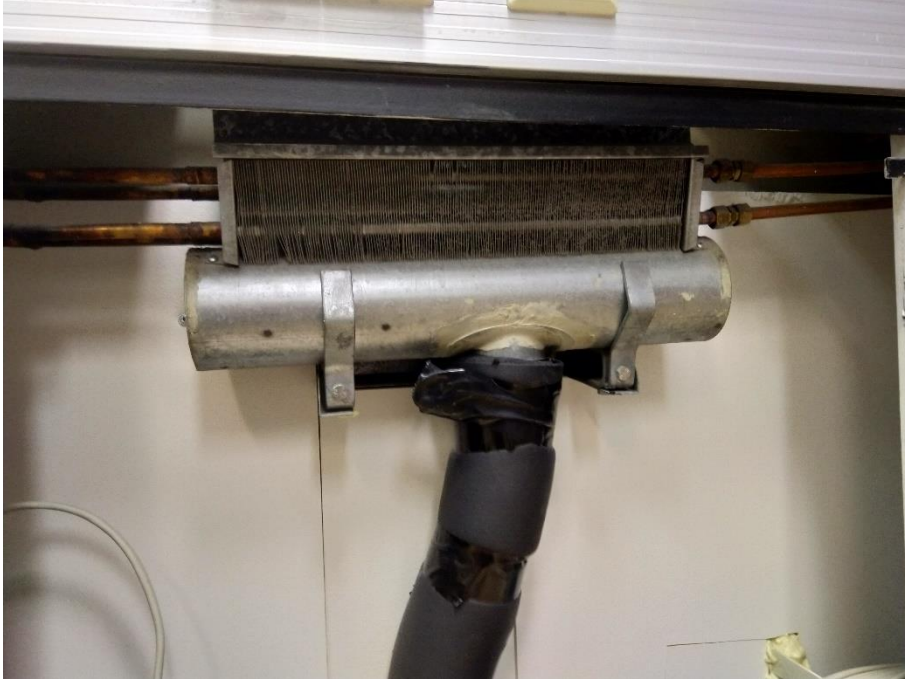
KUVA 2. Suutinkonvektori lämmityspatterilla
