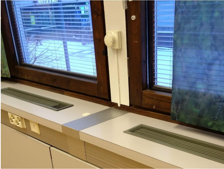
KUVA 3. Lämmönsäätöyksikkö
