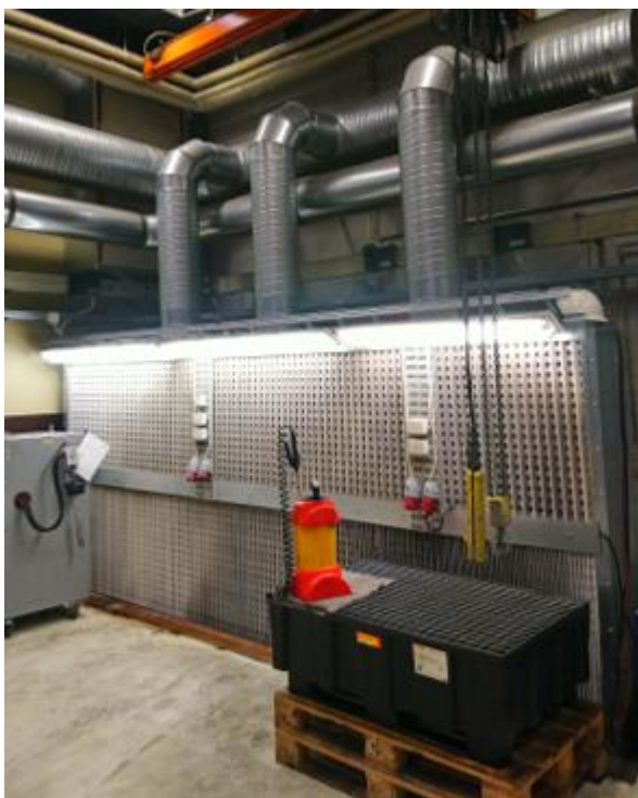
Kuva 6. Väliaikainen suojanesteen levityspaikka imuseinällä.
