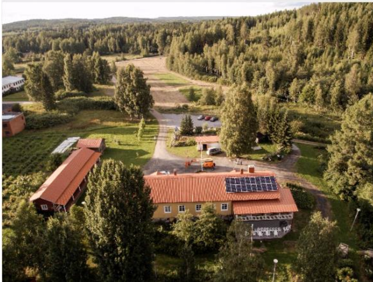
Kuva 7. Ilmakuva Haikolan talon aurinkosähköjärjestelmästä (Solar.web).
