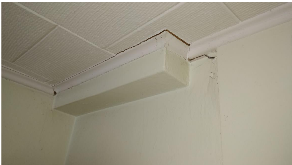
Kuva 21. Makuuhuoneen hormin yläosa (Kalle Komulainen 2019-03-17)
