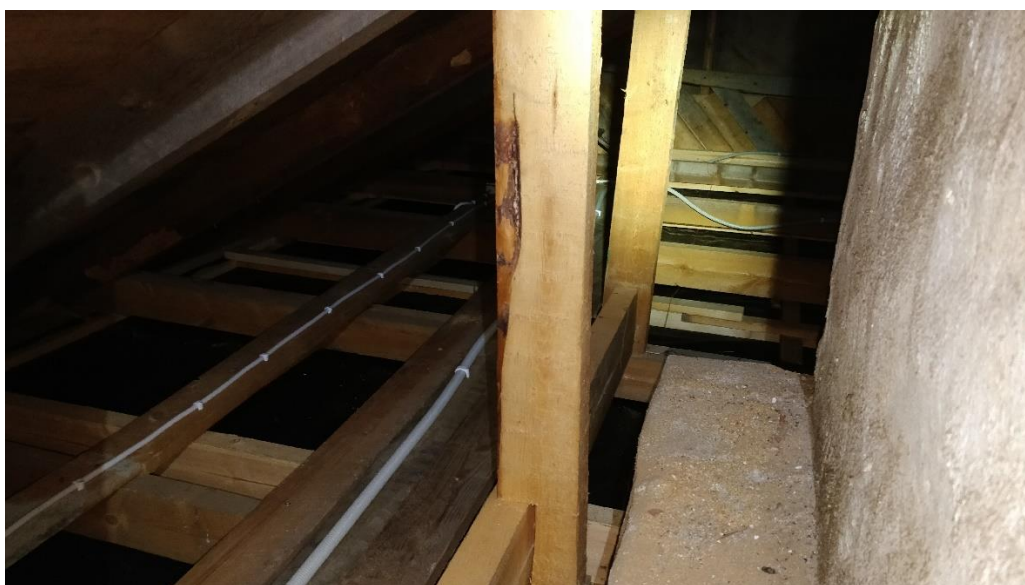
Kuva 13. Yläpohja, hormin vierus (Kalle Komulainen 2019-03-17)
