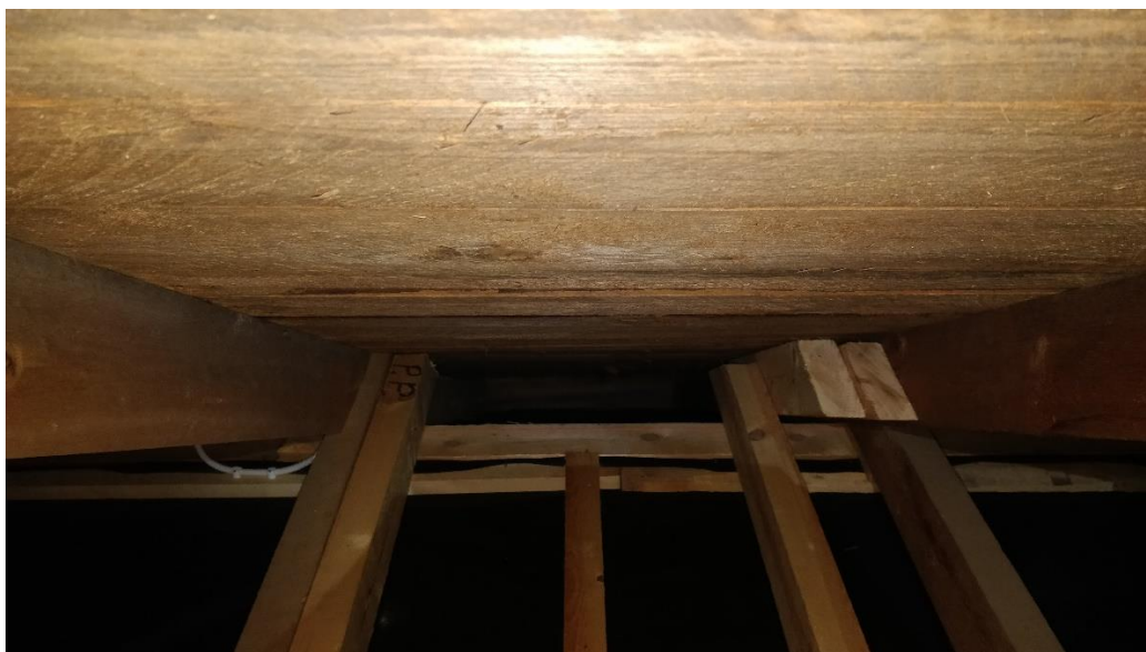
Kuva 12. Yläpohja, katon lape räystäälle (Kalle Komulainen 2019-03-17)
