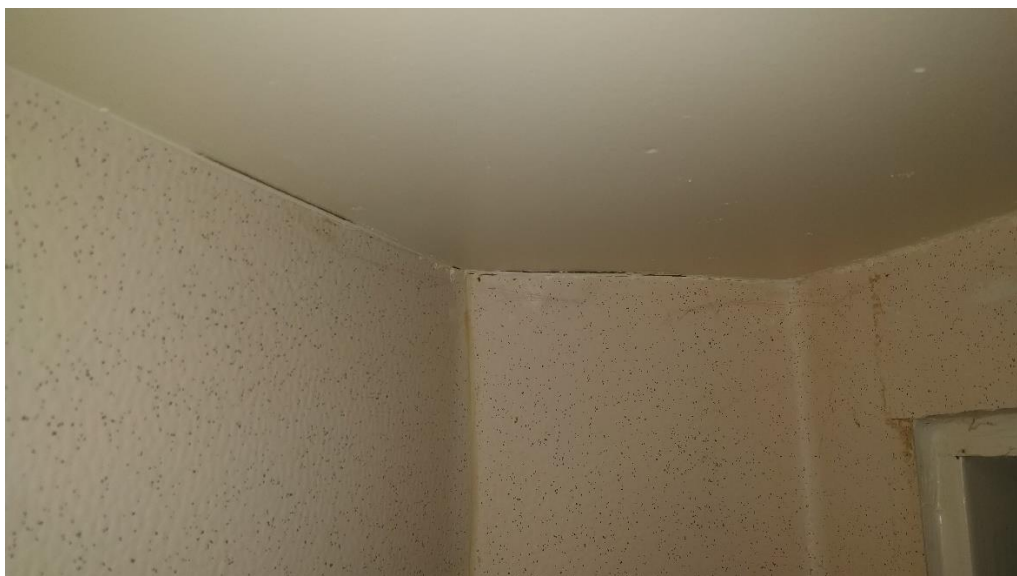
Kuva 18. Märkätilan kotelon saumat (Kalle Komulainen 2019-03-17)
