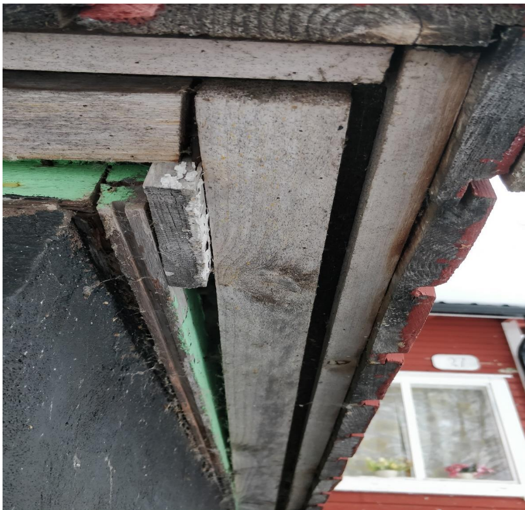
Kuva 14. Kasvatettu seinärakenne (Kalle Komulainen 2019-03-17)
