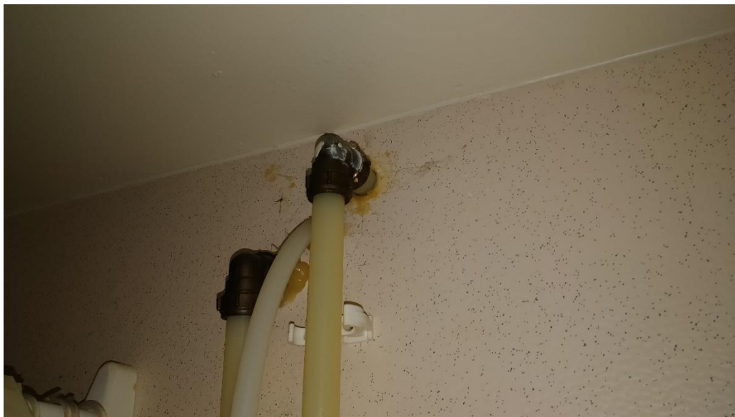
Kuva 17. Märkätilan vesiputkien läpivienti (Kalle Komulainen 2019-03-17)
