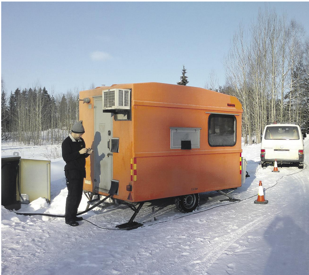
Fiberablarna kopplas i anslutningsskåpen. Därifrån går sedan kabeln vidare till abonnenten. FOTO: Yngve Källberg
