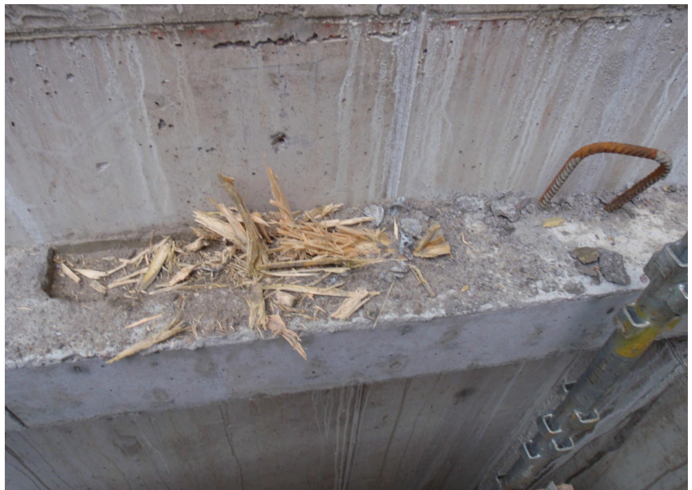
Kuva 3. Konsoliin jäänyt puunpala.
