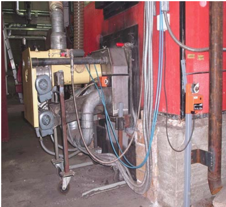
KUVIO 11. Kunniavuoren pellettilämpölaitoksen pellettipoltin
