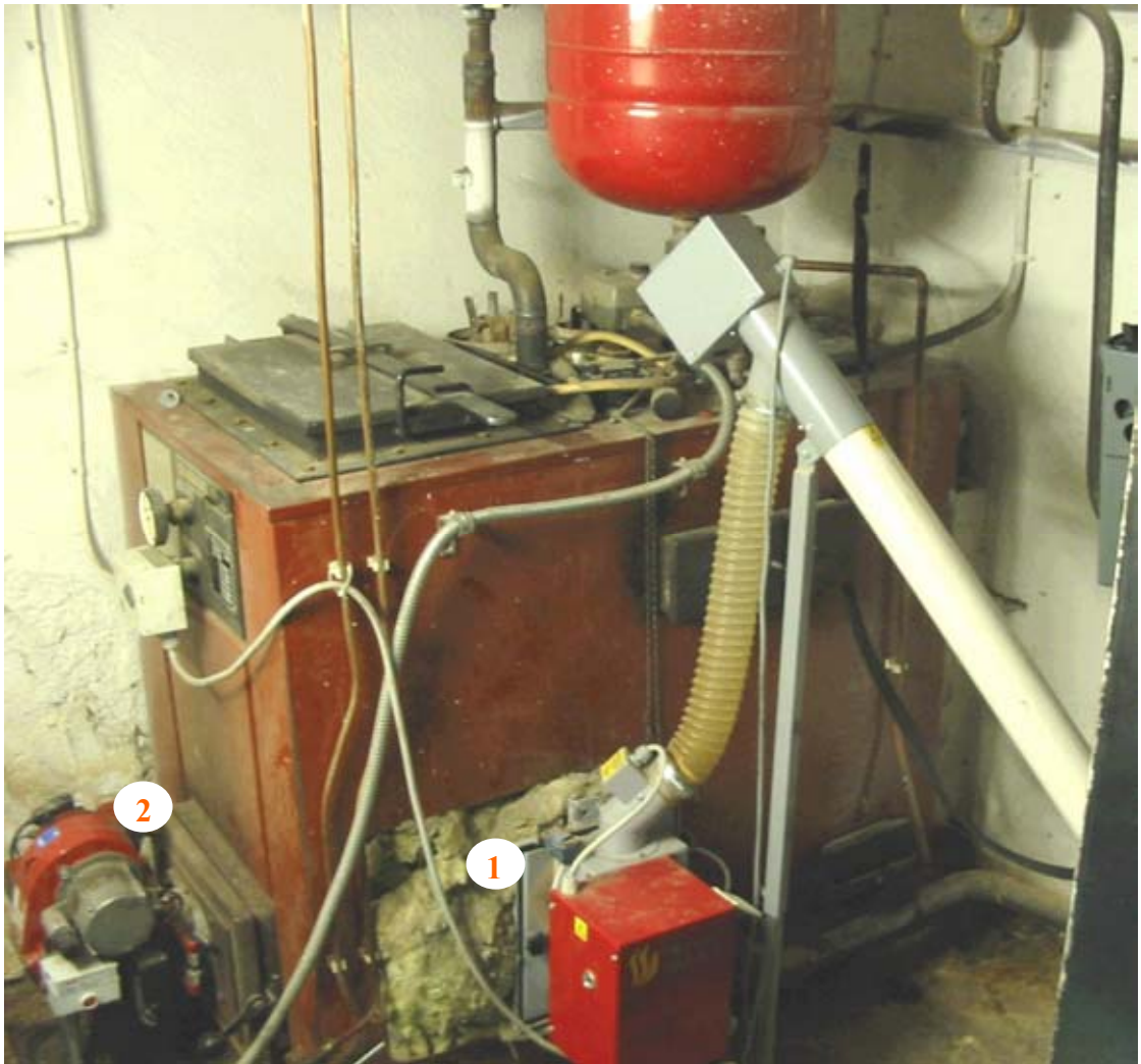
KUVIO 16. Marttisen pannuhuone (1. Pellettipoltin 2. Öljypoltin)
