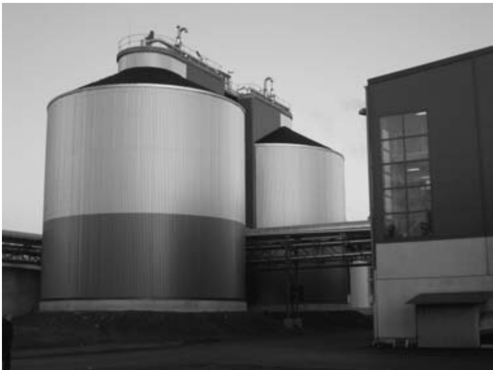
Biokaasusta energiaa Keski-Suomeen -hankkeessa 29.10.2008 järjestetyllä biokaasuopintomatalla tutustuttiin eri kokoluokan biokaasulaitoksiin. Kuvassa Ilmajoella sijaitseva Lakeuden etappi Oy:n biokaasulaitos, joka käsittelee mm. biojätettä ja jätevedenpuhdistamoiden lietteitä. Lopputuotteena syntyy energiaa ja lannoitepellettiä.
