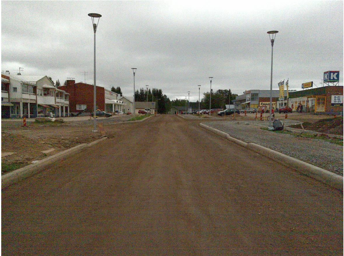
KUVA 18. Asematie rakennustöiden aikana 24.8.2009
