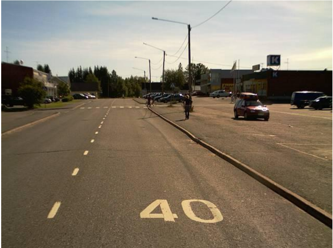
KUVA 17. Asematie ennen vuoden 2009 rakennustöitä (10)
