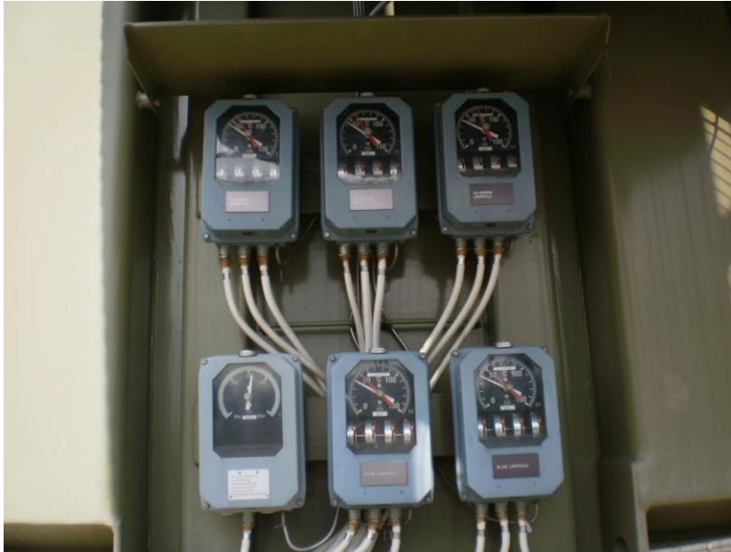
Figur 9. Flera temperaturvakter som indikerar bl.a. olje- och lindningstemperaturen (Fotograf Jami Lehtinen Hikiä 2010)
