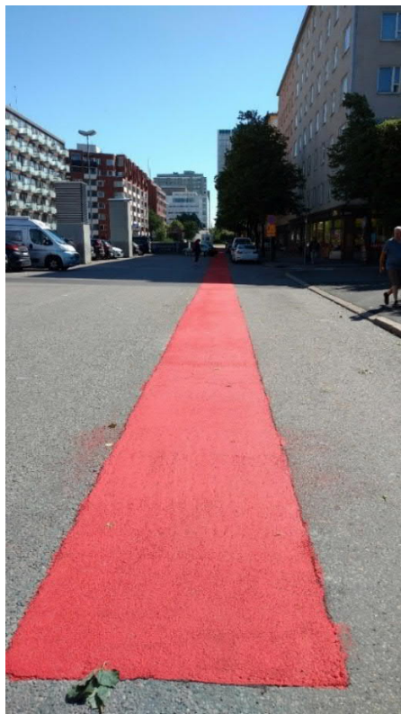
Kuva 46. Barrikade Traffic-pinnoite asennettuna Sörnäisten rantatielle. Kaistamerkinnyt puuttuvat (Honkasalo, 2018).
