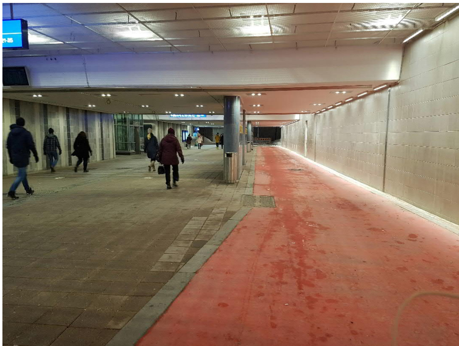
Kuva 47. Leppävaaran asematunnelin Barrikade Traffic-pinnoite (Rautio, 2018).
