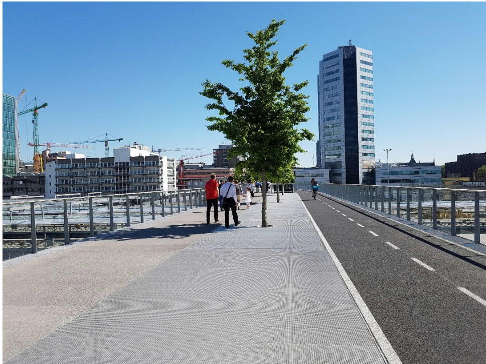
Kuva 8. Jalankululle ja pyöräilylle varattu silta Utrechtissä, jossa toiminnallisuuden, turvallisuuden ja viihtyisyyden on kiinnitetty erityistä huomiota. Jalankulku ja pyöräily on erotettu toisistaan leveällä välikaistalla, johon on istutettu puita. (Rautio, 2018)
