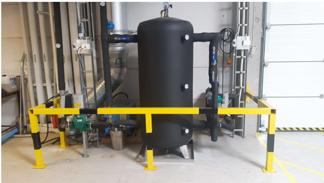
Kuva 10. Rakentamani turvakaide jäähdytysputkien suojelemiseksi.
