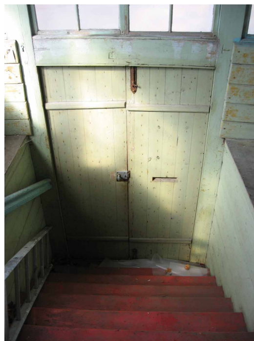
KUVA 9 Ulko-ovet sisäpuolelta kuvattuna
