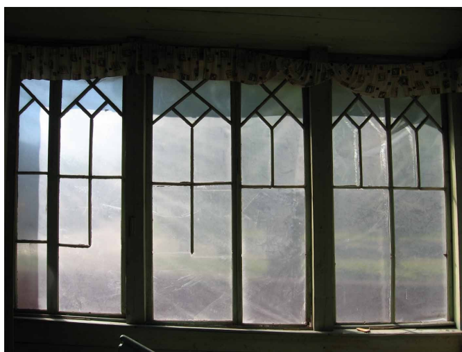
KUVA 23 Ikkunoita sisältäpäin kuvattuna
