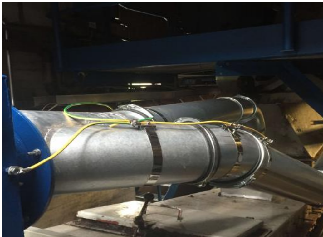
Kuva 2. Sarjamaadoittamisen toteuttaminen putkistolinjassa.
