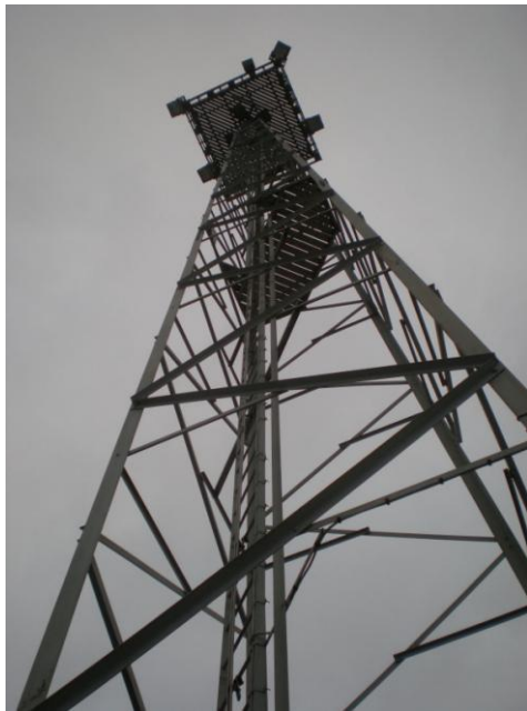
Kuva 3 Tukirakenteita, joita myös himmelissä esiintyy.
