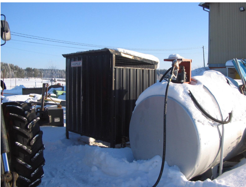
6. Kaasupullojen varastointipaikka sekä Farmisäiliö
