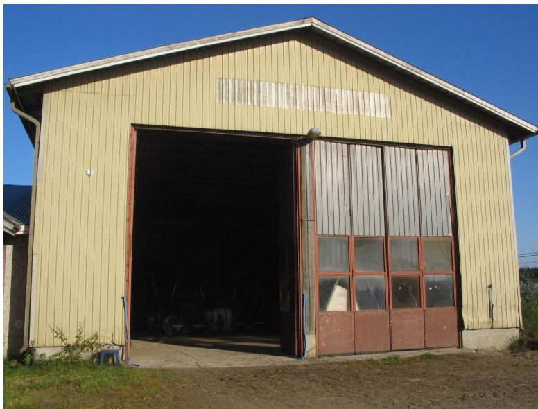
KUVA 3. Ravitallin yhteydessä oleva heinälato toimii varastona sekä rakennuksen toisena poistumisreitteinä. (Taivassalo 2008)
