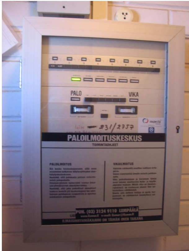
KUVA 16. Paloilmoituskeskus sijaitsee ratsutallin tuulikaapissa. (Taivassalo 2009)
