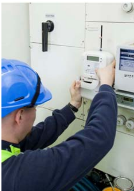
Kuva 5. AMM-mittarin asennus
