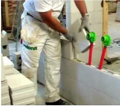
Kuva 5. LVIS- putkien asennus kahi-seinään (Weber 2017)
