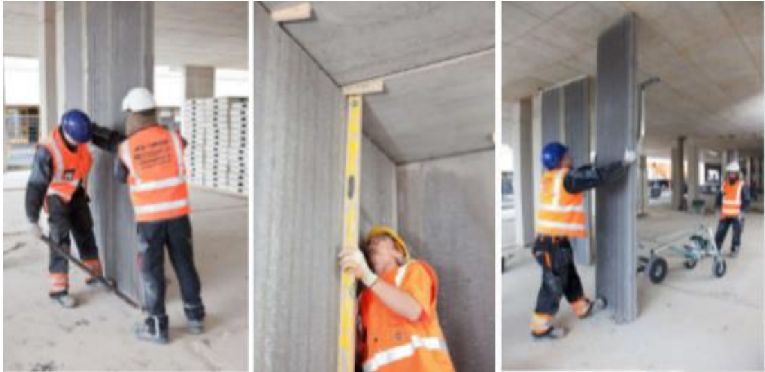
Kuva 10. AKO- elementtien asennusta (Rakennusbetoni 2014)
