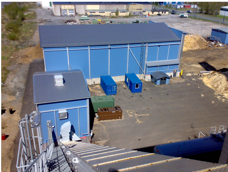
Kuva 7. Polttoaineen vastaanottohalli ja seulomo
