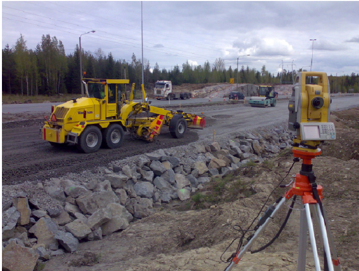
Kuva 6. Takymetriohjattu tiehöylä työmaalla /4./
