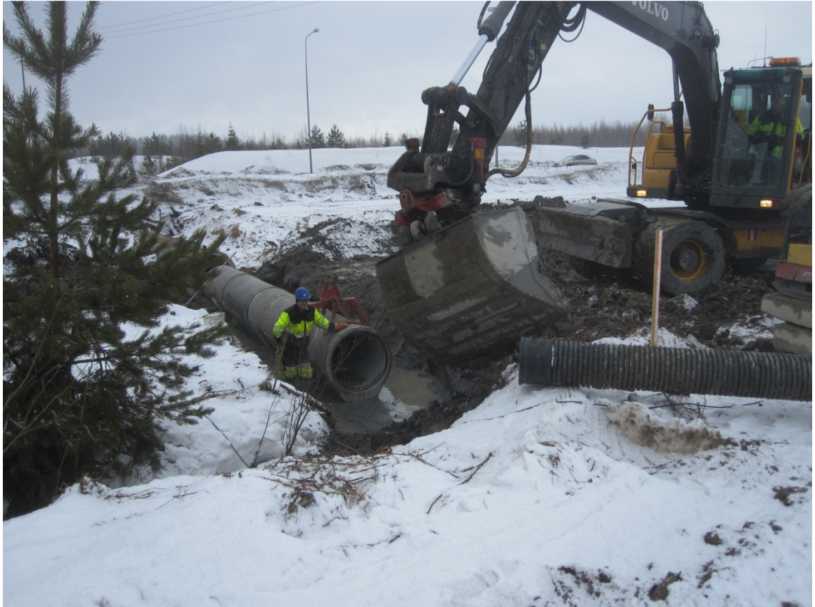
Kuva 22. Kaivutyössä ei tarvita korkomerkkejä maastoon
