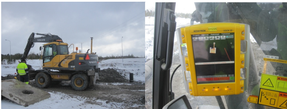
Kuva 18. Satelliittivastaanotin ja näyttö työkoneessa
