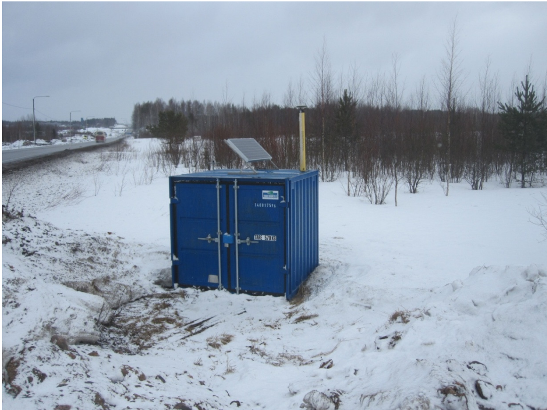
Kuva 19. Konttiin sijoitettu tukiasema työmaalla
