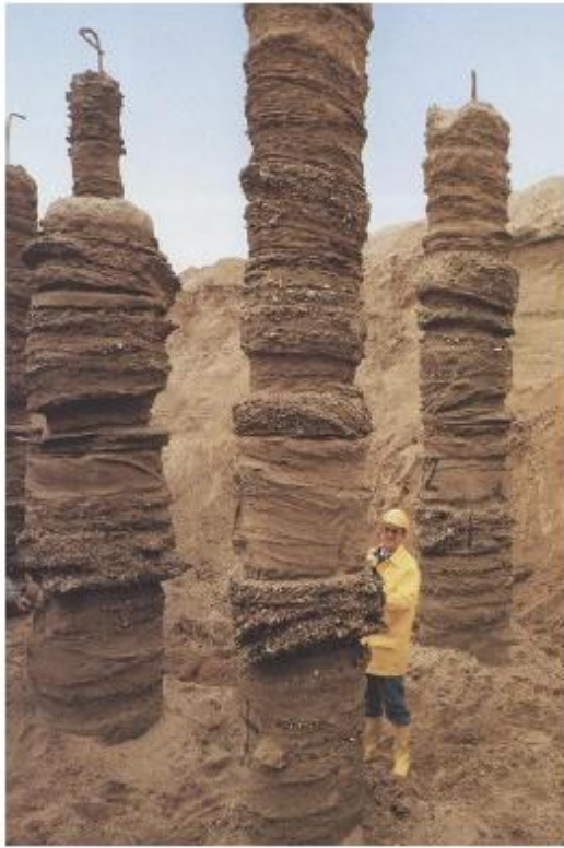
Figur 14. Färdiga jetpilar. (Bilfinger Berger Foundations, 2011)
