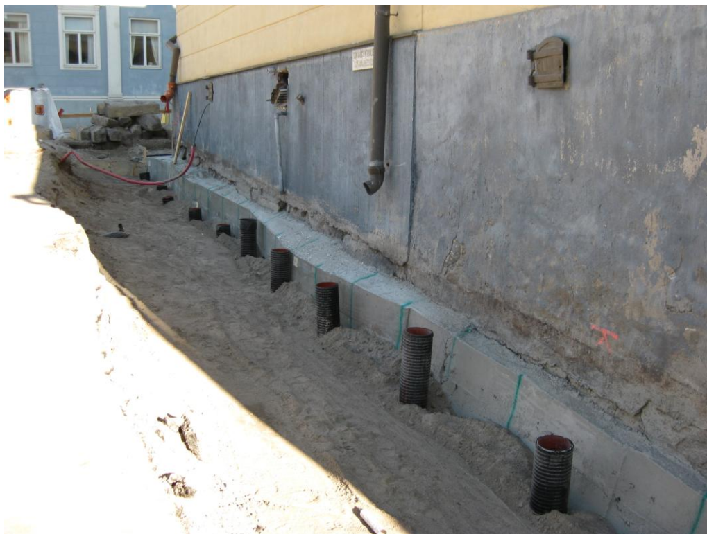
Figur 17. Förberedande arbeten färdigt gjorda. Mantling av gamla sockeln, skyddsror vid injekteringshål samt injekteringsdike grävt. 11.6.2010
