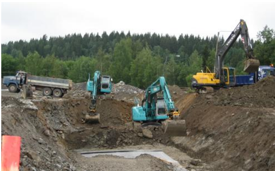
Figur 1. Schakt med slänt (Uutelan Maansiirto Oy 2.3.2011 )
