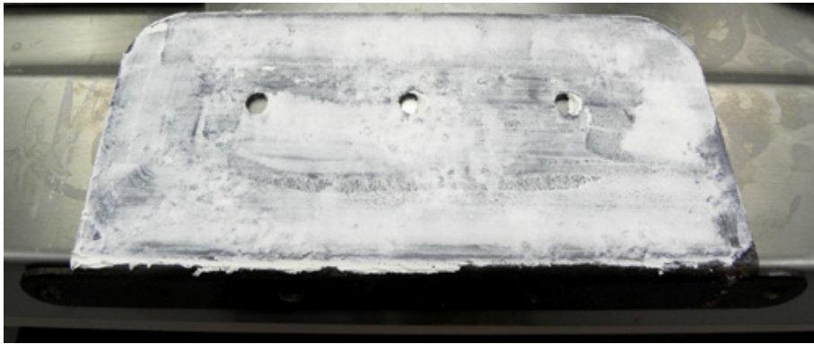
Kuva 26. Paristoa paikallaan pitävä metallilevy. Metallilevy on kitattuna. (Ranta 2011.)
