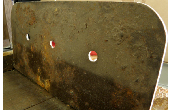
Kuva 30. Metallilevy, jonka päällä paristo on ollut. (Ranta 2011.)
