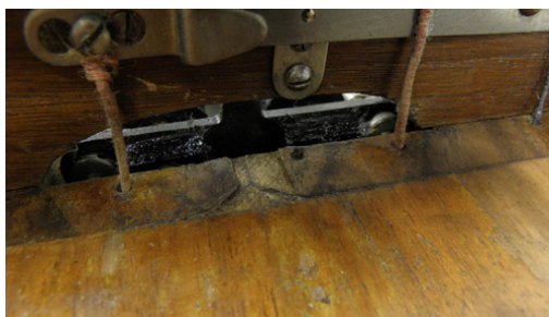
Kuva 45. Seinäpuhelimen sisällä oleva viiluvaurio. (Ranta 2011.)
