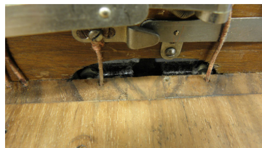
Kuva 46. Valmis viilupaikka seinäpuhelimen sisällä. (Ranta 2011.)
