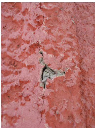
Kuva 12. Hirren pääty rappauksen alla (Laakso 2011).
