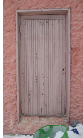
Kuva 53. Pohjoispäädyn ovi (Laakso 2011).
