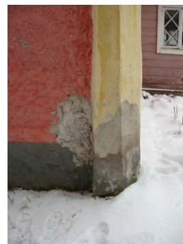
Kuva 33. Pilasterin ja seinän nurkkauksen korjaus (Laakso 2011).
