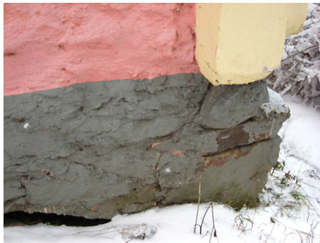
Kuva 47. Nurkan rapautunutta maalipintaa ja kolo alhaalla vasemmalla (Laakso 2011).
