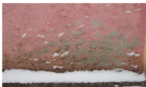
Kuva 20. Maalin rapautumista seinän alaosasta (Laakso 2011).
