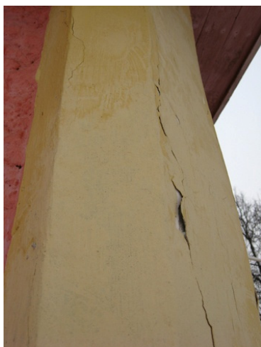
Kuva 18. Halkeama ja sen irtonainen reuna (Laakso 2011).
