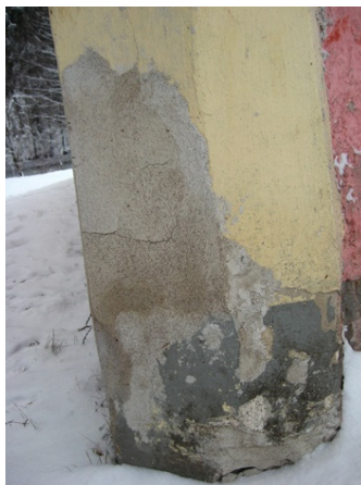
Kuva 31. Pilasterin alareunan paikkaus sekä maalipinnan rapautumista (Laakso 2011).
