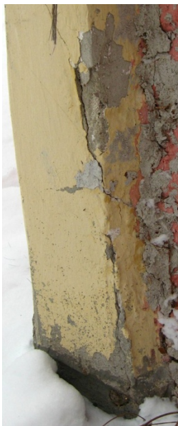
Kuva 49. Pylvään ja seinän nurkkaan tehty korjaus (Laakso 2011).
