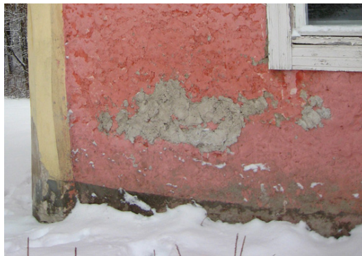
Kuva 30. Korjausalue ikkunan ja pilasterin välisellä seinäalueella (Laakso 2011).
