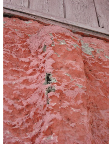
Kuva 35. Reikä rappauksessa puupinnalle asti korokkeen yläosassa (Laakso 2011).
