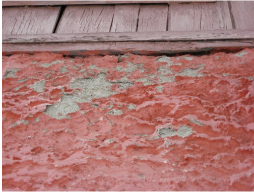
Kuva 34. Korokkeen yläreunan lähellä näkyvää rapautumista (Laakso 2011).
