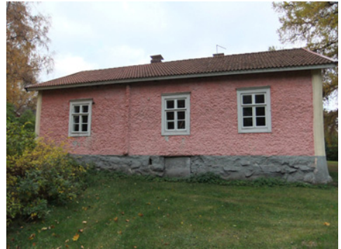
Kuva 39. Länsiseinä kesällä 2010 (Tuhkanen 2010).
