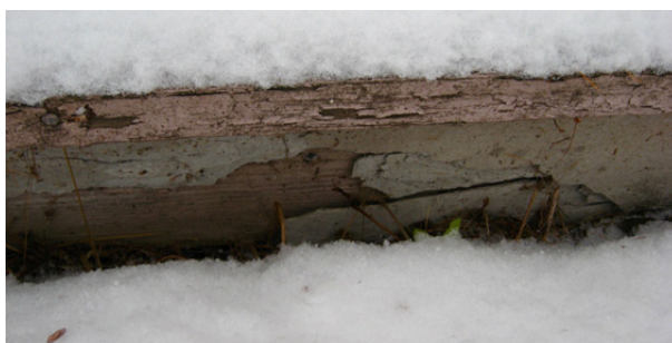
Kuva 25. Halkeillut levy ja alla näkyvä lautapinta (Laakso 2011).
