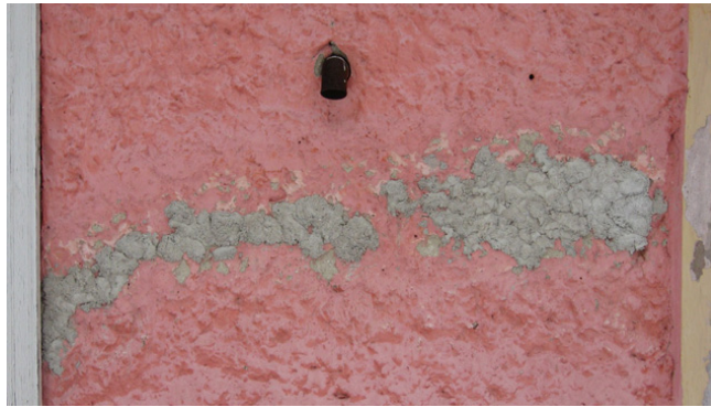
Kuva 21. Putken alla oleva korjausalue (Laakso 2011).
