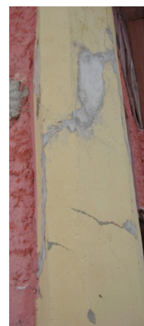
Kuva 17. Pilasterin uusi korjaus (Laakso 2011).
