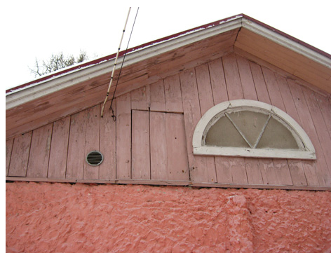
Kuva 51. Tuuletusritilä ja ullakolle johtava luukku (Laakso 2011).
