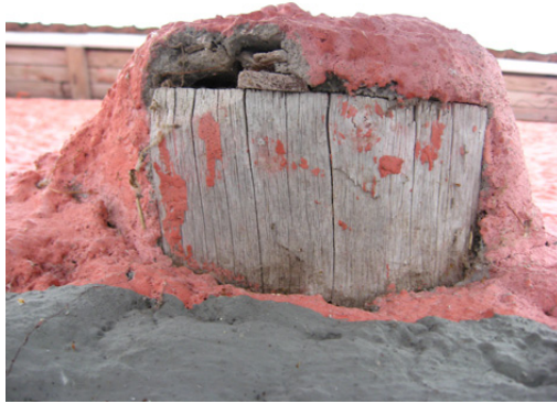
Kuva 44. Korokkeen alareuna ja alareunasta puuttuva pala (Laakso 2011).
