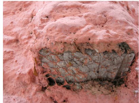
Kuva 48. Korokkeen alla näkyvä metalliverkko (Laakso 2011).
