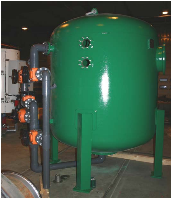
Kuva 11. Suomenojan uusi pehmennyssuodatin (32).
