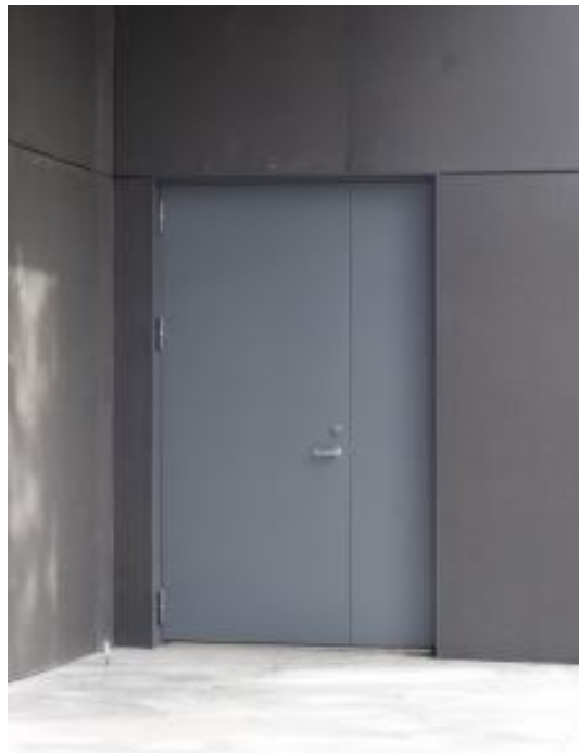
Kuva 11. Teräsrakenteinen ulkopalo-ovi EI60. (Lähde: Internet: http://sakumetall.ee . 31.3.2011)
