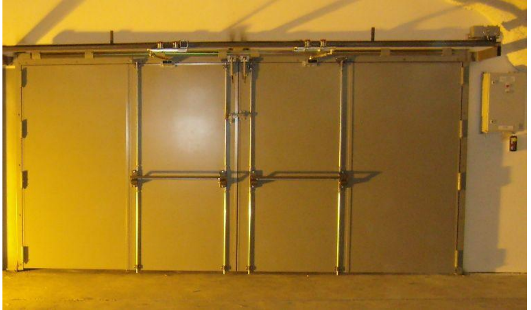
Kuva 10. Teräsrakenteinen taittopalo-ovi EI90. (Lähde: Internet: http://saajos.fi . 31.3.2011)
