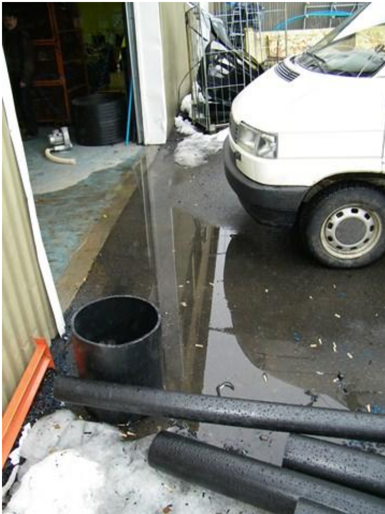
Kuva 3. Keväisin vesi kerääntyy tehdashallin oven eteen.
