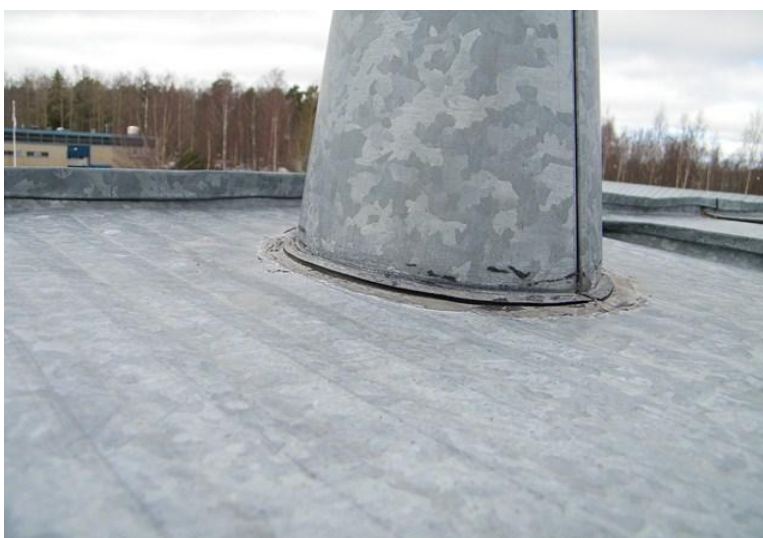
Kuva 17. Tehdashallin katon eteläpuoleisen reunan pellistä irronnut ilmanvaihtohattu.
