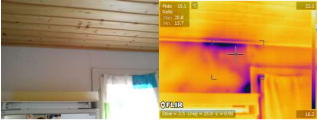
KUVA 33. Kylpyhuone: Yläpohjan ja ulkoseinän välinen liitos 50 Pa:n alipaineen vallitessa.
