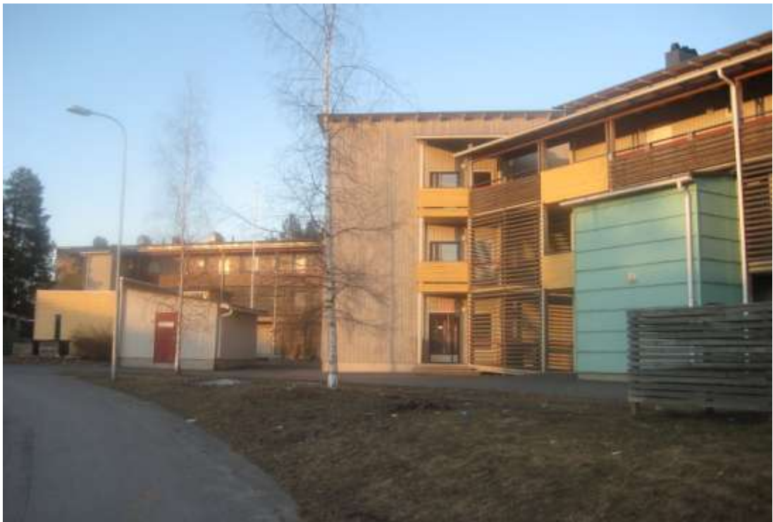
KUVA 4. Kiinteistö Oy Puukotka
