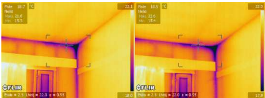
KUVA 28. Yläpohjan, ulkoseinän ja huoneistojen välisen seinän liitos. Vasemmalla ennen paineistusta, oikealla 50 Pa:n alipaineen vallitessa.
