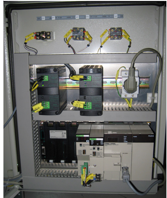
Kuva 3.2.5. Sähkökaapin oikea ovi työn jälkeen.
