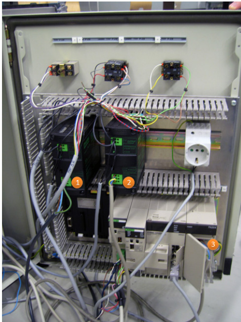
Kuva 3.2.4. Sähkökaapin oikea ovi ennen työtä.
