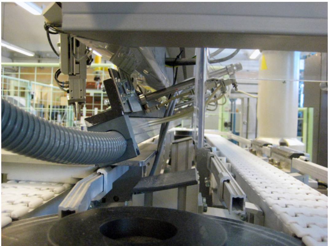
Kuva 3.5.2. Irrallaan olevat sylinterit asennettu suunnittelulle paikalle.
